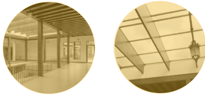
Hormigón, cubierta tipo Eternit con plancha translucidas en algunos sectores.
