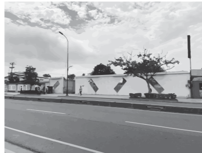
6. Av. 25 de Junio: Fachada principal del lote, se encuentra en una de las principales avenidas de la ciudad.
