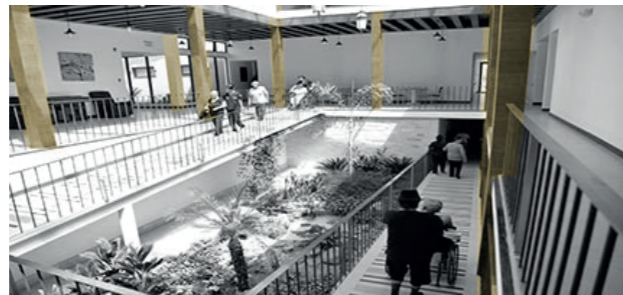
Utilizan una estructura modular con columnas de materiales mixtos: Hormigón armado y en el patio central, utiliza columnas y una pérgola de madera.
