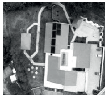
Se adapta a la topografía del lugar, cuenta con un patio central, vegetación, iluminación natural y utilizan materiales tal como la madera.
