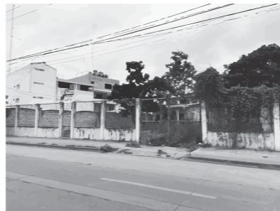
1. Calle Loja: El terreno posee cerramiento perimetral con puertas de garaje y vegetación con falta de mantenimiento.
