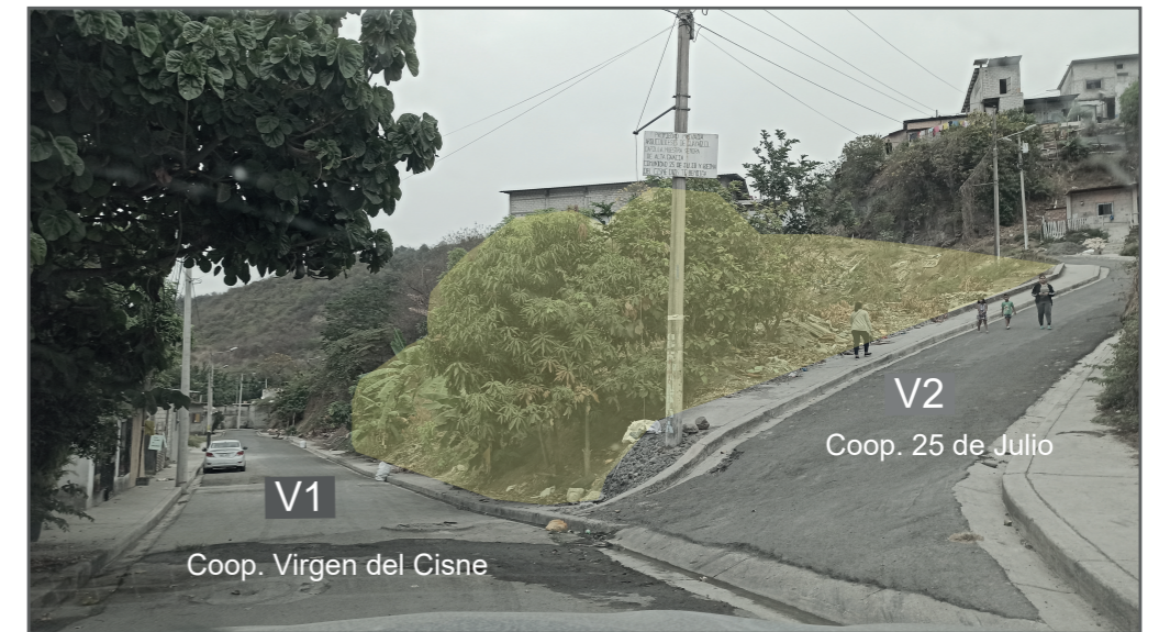
Figura 10. intersección V1 y V2, diferencia de pendientes
