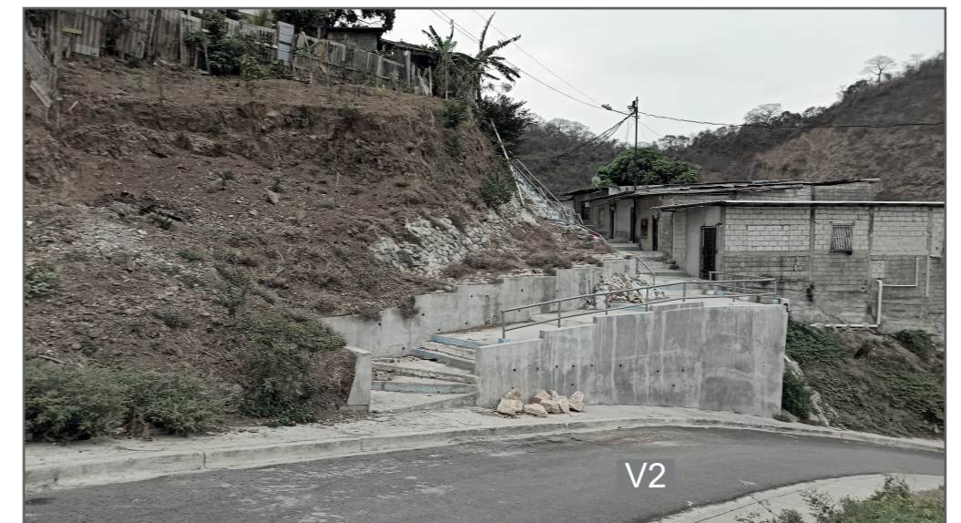
Figura 11. Escalinatas, lado norte del terreno
