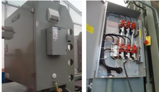
Figura 3. 32 Puntos de ligación para alimentación CA externa
