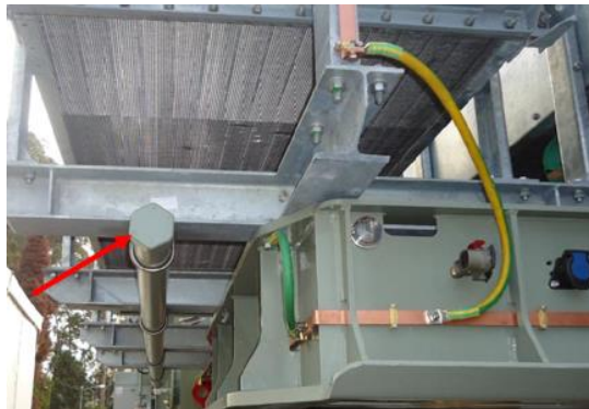
Figura 3. 22 Ubicación de almacenamiento de los cables de conexión durante el transporte
