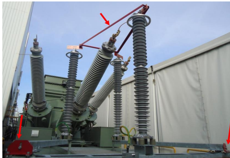
Figura 3. 8 Ubicación de las estructuras a remover en semirremolque del transformador de potencia lado AT
