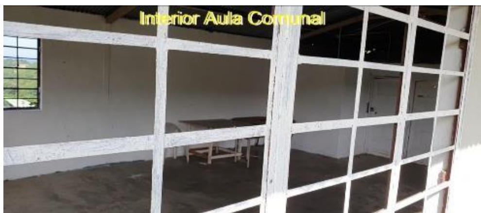
Figura 4. 2 Interior de aula comunal
