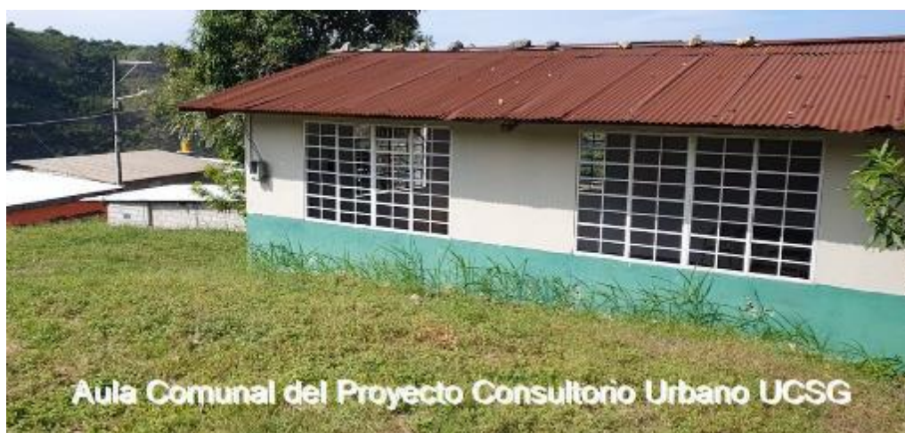
Figura 4. 1 Vista del aula comunal del proyecto Consultorio Urbano
