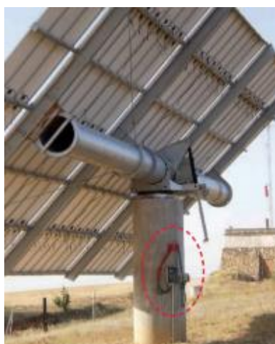
Figura A. 4 Caja de conexiones de un módulo fotovoltaico.
