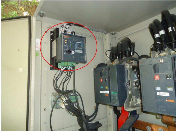
Figura 36. Ubicación del sistema de control automático de transferencia
