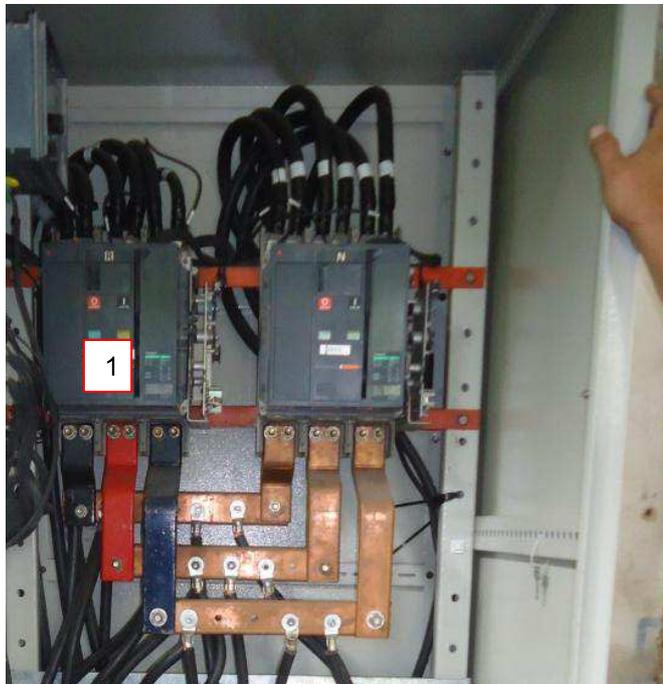
Figura 37. Breaker principal del panel de transferencia No1
