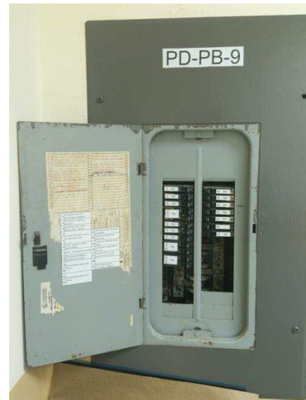
Figura 84.2-PD-PB-9, Después Marquillaje
