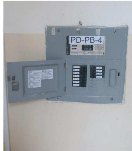
Figura 79.2-PD-PB-4, Después Marquillaje
