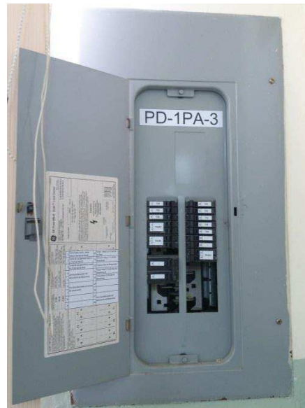
Figura 88-PD-1PA-3, Después Marquillaje
