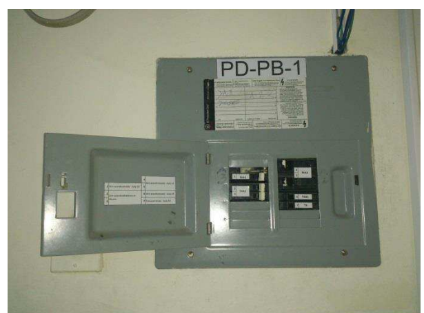
Figura 76.2-PD-PB-1, Después de Marquillaje
