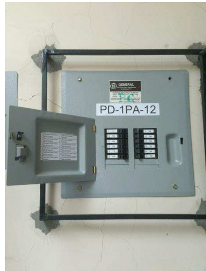
Figura 97.2-PD-1PA-12, Después Marquillaje
