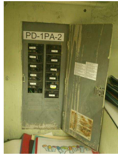
Figura 87.2-PD-1PA-2, Después Marquillaje
