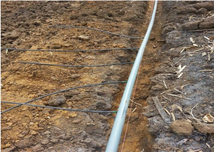
Figura 2. Instalación del sistema de riego.
