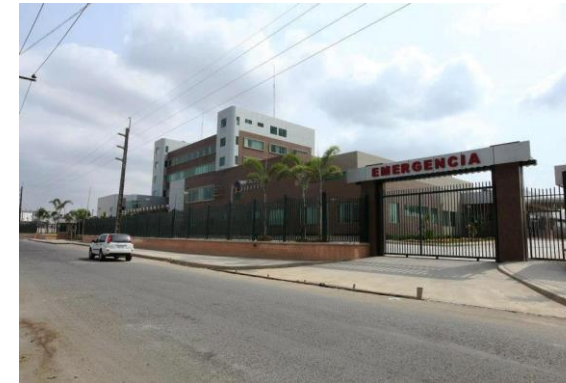
Figura 116. Vista exterior del ingreso área de emergencia del IESS Hospital de Babahoyo.
