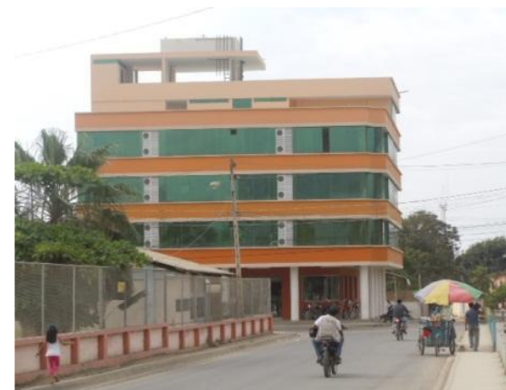
Figura 83. Z3: Zona Residencial, Residencia en el centro de la Cabecera Cantonal.
