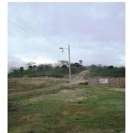
Figura 74. Presencia del tendido Eléctrico en el terreno seleccionado.
