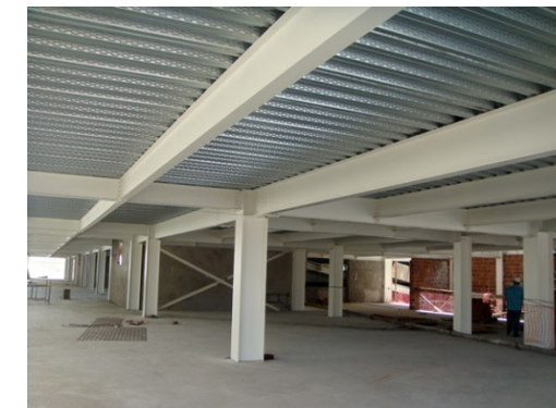
Figura 129: Losa alivianada con panel metálico. Fuente: VAOLIVRE (2012)
