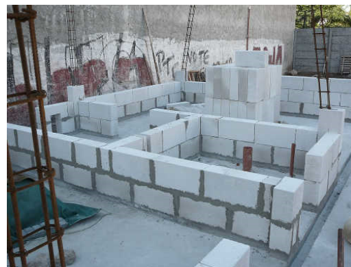
Figura 121: Levantamiento de paredes de bloques de hormigón. Fuente: Elías (2012)
