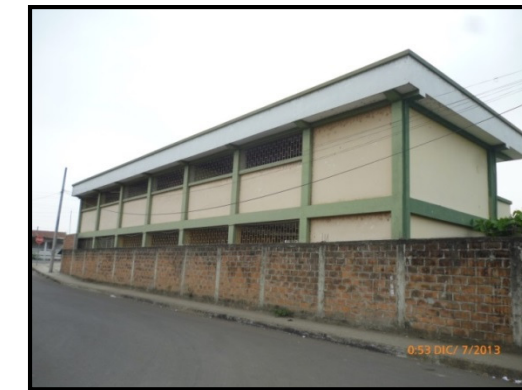
Figura 47: Imágenes de las vías del sector, punto 3 Fuente: Mendoza (2013)
