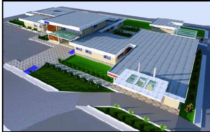
Vista superior desde área de Emergencia
