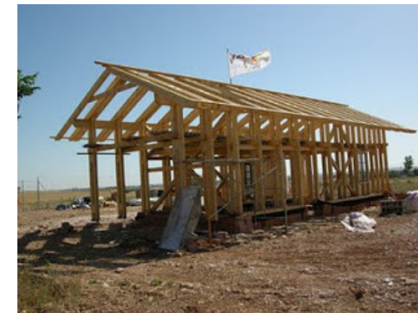
Figura 115: Estructura de madera. Fuente: Ecohabitar (2013)
