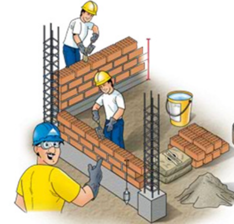
Figura 124: Levantamiento de paredes de ladrillos de arcilla. Fuente: Aceros Arequipa (2012)
