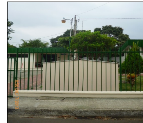
Figura 38: Instalaciones para agua potable en la UAA-Calceta. Fuente: Mendoza (2013).
