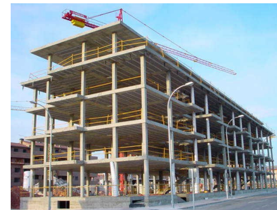
Figura114: Estructura de hormigón armado. Fuente: (Mosquete (2009))
