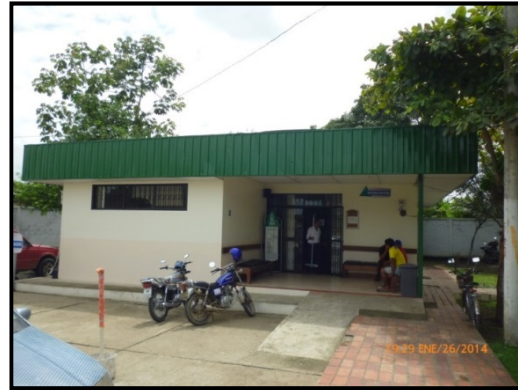
Figura 87: Vista frontal del área de rehabilitación. Fuente: Mendoza (2013).
