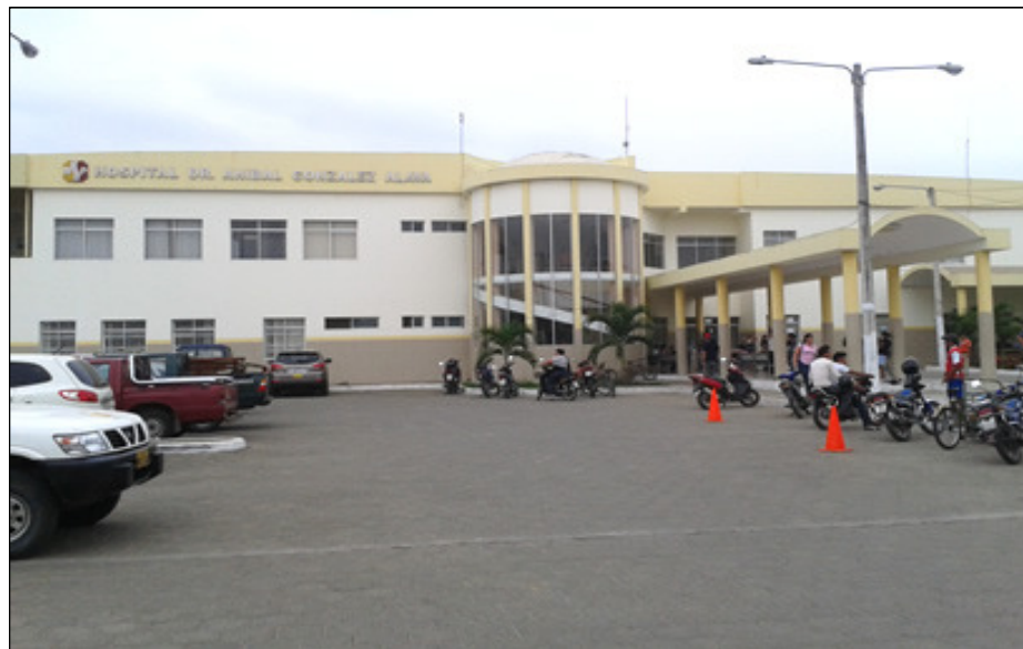
Figura 93: Vista frontal del Hospital Básico "Anibal Gonzales Álava". Fuente: Briones (2012)
