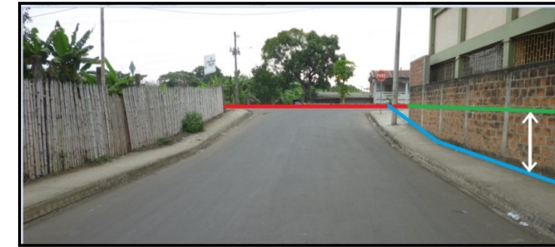
Figura 32: Diferencia de nivel entre el sector y la Vía Principal de acceso. Fuente: Mendoza (2013).
