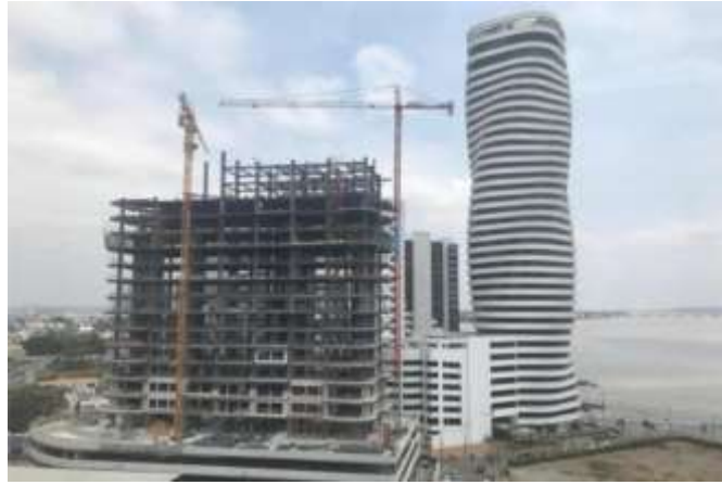
Ilustración 19 Sistema Estructural: Pórtico de acero laminado con muros estructurales de hormigón armado
