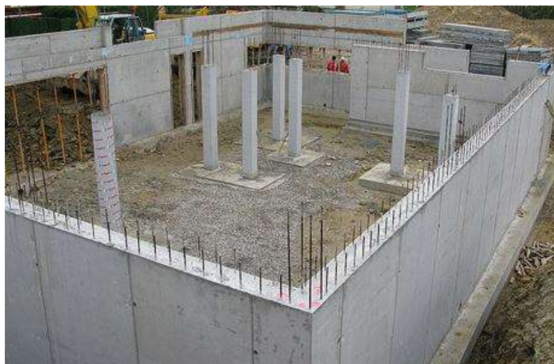
Ilustración 1 Sistema de muros estructurales
