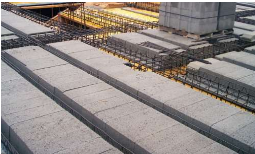
Ilustración 2 Sistema de losa aligerada unidireccional
