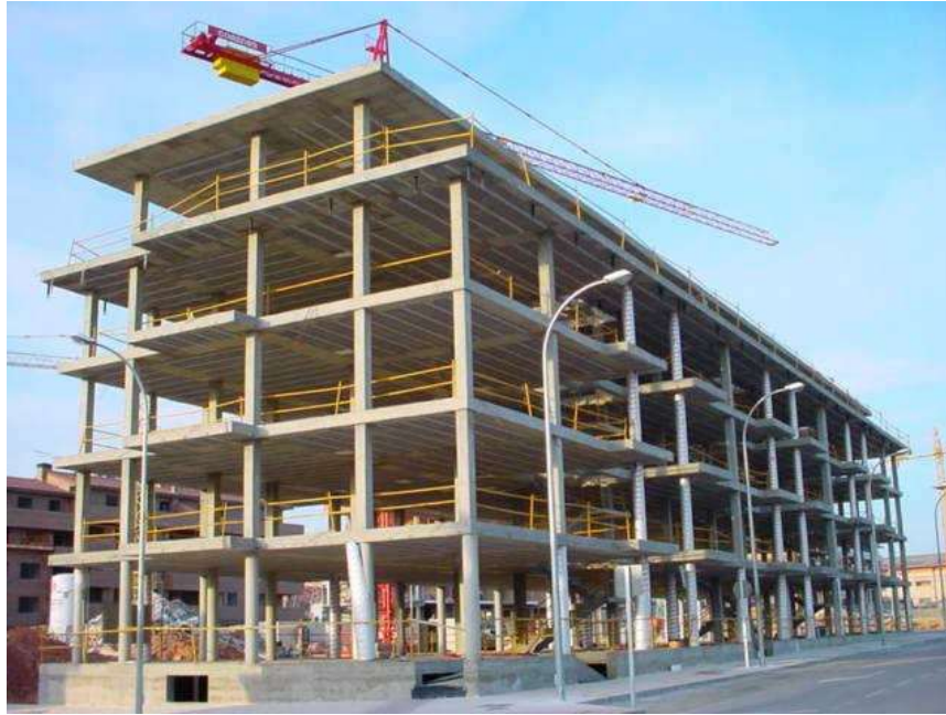
Ilustración 12 Sistema Estructural: Pórticos de hormigón armado
