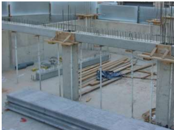
Ilustración 3 Sistema compuesto; pórtico de Hormigón Armado
