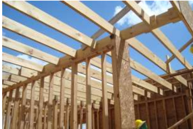
Ilustración 8 Sistema Estructural: Madera (W1)
