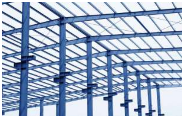
Ilustración 16 Sistema Estructural: Pórtico acero laminado
