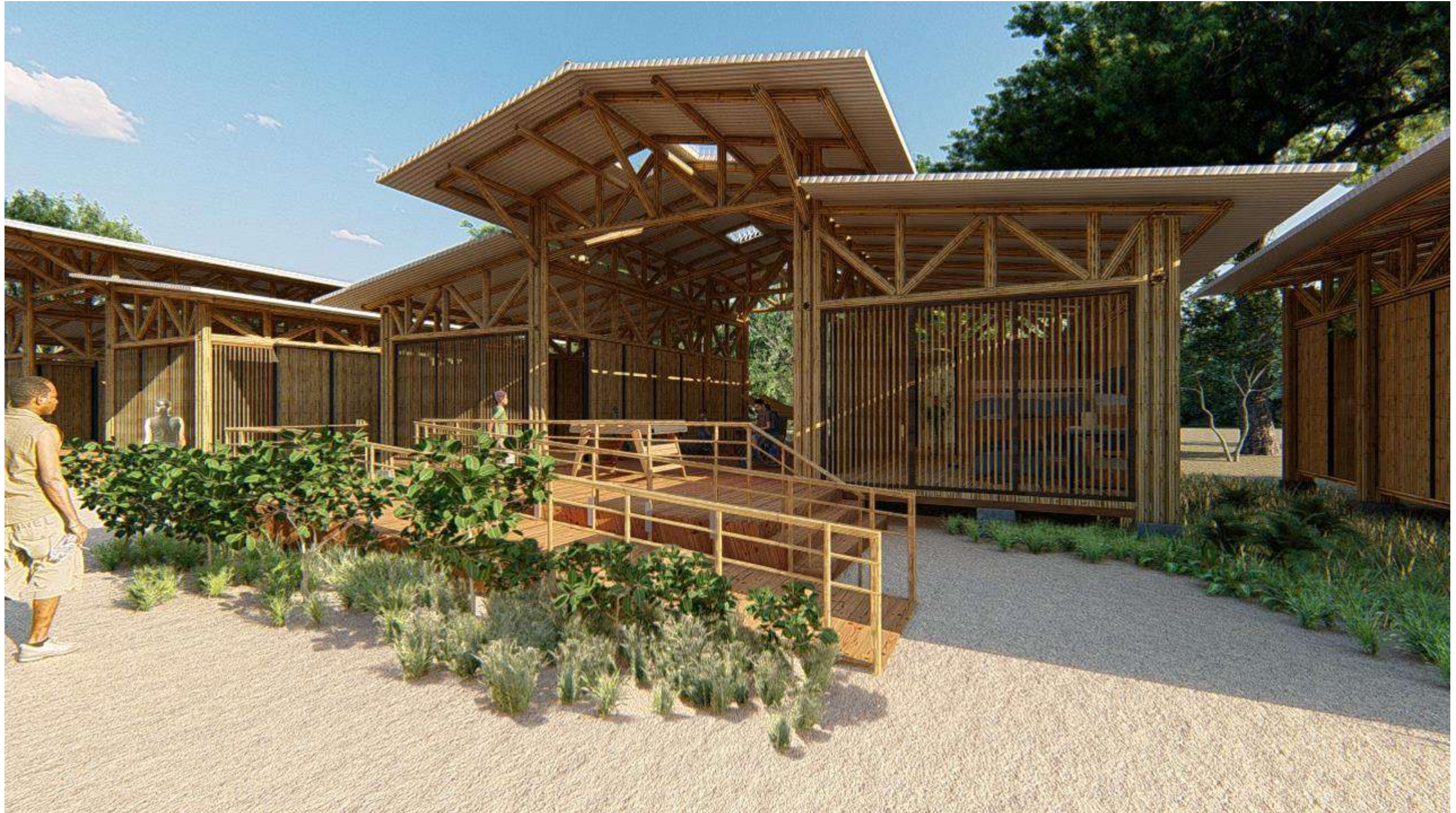
FACHADAS DE LOS ALOJAMIENTOS DE ESTUDIANTES CON RAMPA PARA DISCAPACITADOS
