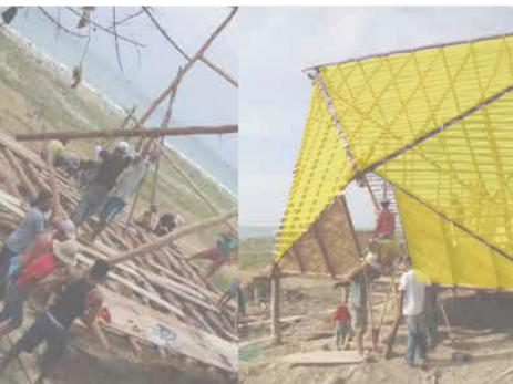
Se usa la misma construcción del sector en el que las paredes son de caña, base de pilotes, y techo de paja toquilla. Estructura de madera para poder generar la triangulación y formar el barco.
