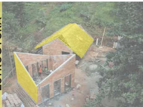
El proyecto cuenta con ladrillos en las paredes como envolvente y permitiendo el ingreso de luz natural y ventilación, y una cubierta de paja recolectada del sector con marco de bambú para cubrir los espacios de interacción.
