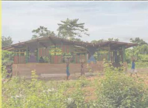
La geometría del proyecto y su orientación se debe a que se quiso disminuir de todas formas la exposición directa al sol e incluir la iluminación indirecta para poder minimizar el uso de iluminación eléctrica y el mantenimiento que se le tiene que dar a la misma.
