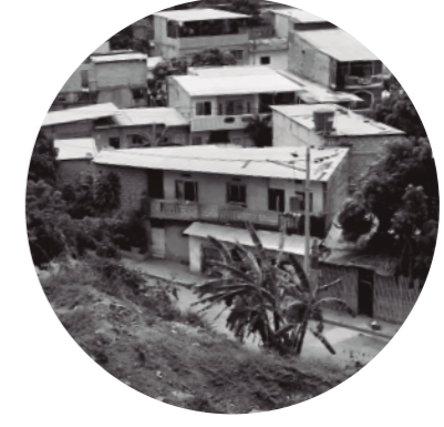
Vista de viviendas de 1 y 2 plantas
