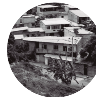
Vista de viviendas de 1 y 2 plantas
