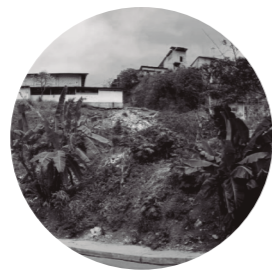
Vista de un área verde deteriorado del sector
