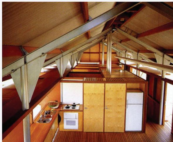
La casa es una estructura de acero a dos aguas sobre una plataforma rectilínea elevada. La estructura descansa sobre pilotes.
