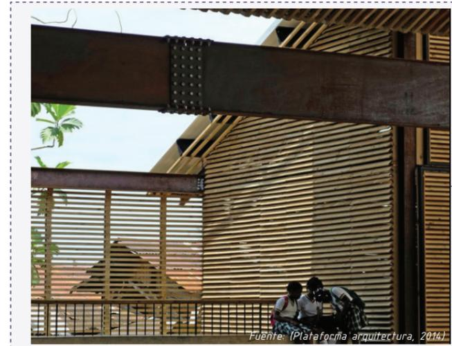
Estructura metálica y paredes de esterilla de madera.
