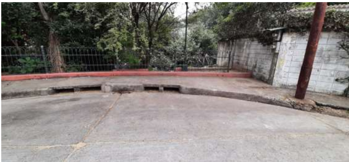
Ilustración 8. Sumidero de Ventana, Callejón 1° Pasaje 34.
