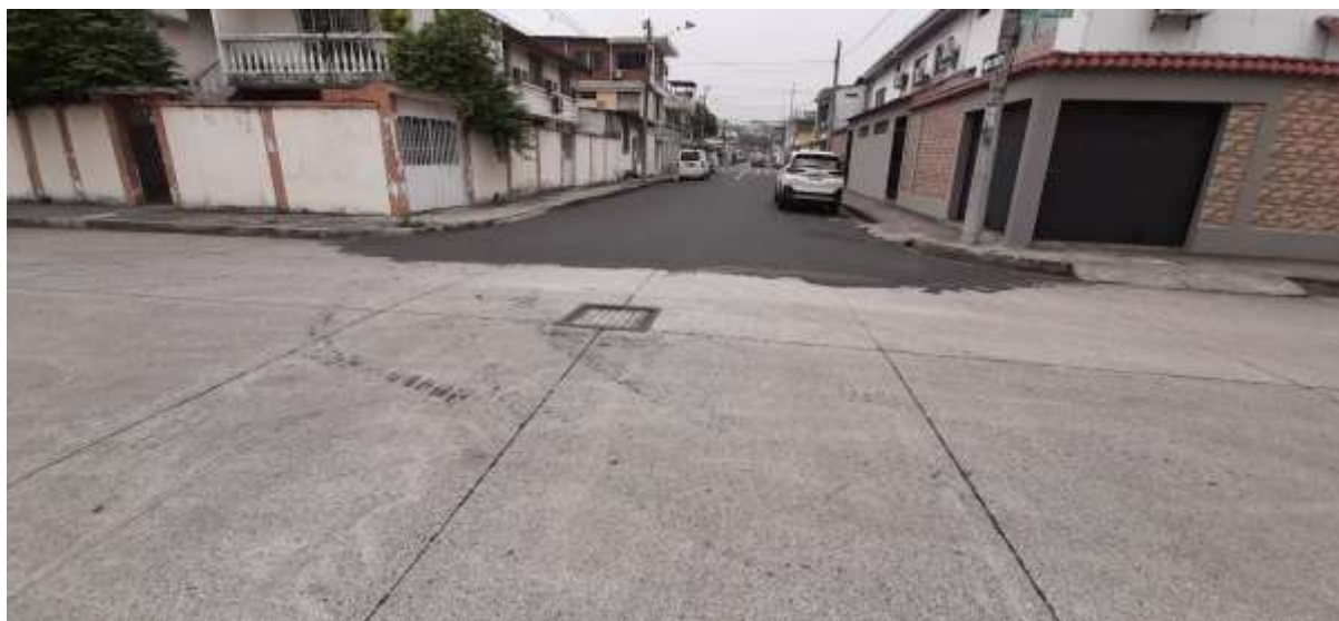
Ilustración 12. Cámara Central, Calle Jiguas y Bálsamos.
