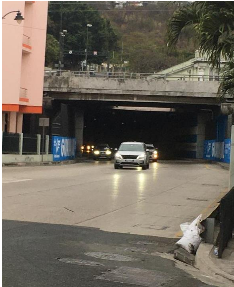
Figura 2. Salida del túnel del cerro Del Carmen
