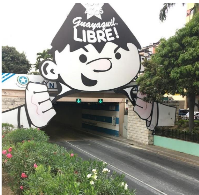
Figura 1. Entrada al túnel del cerro Santa Ana.
