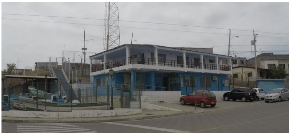
Figura 38 Instalaciones de la guardia costera
