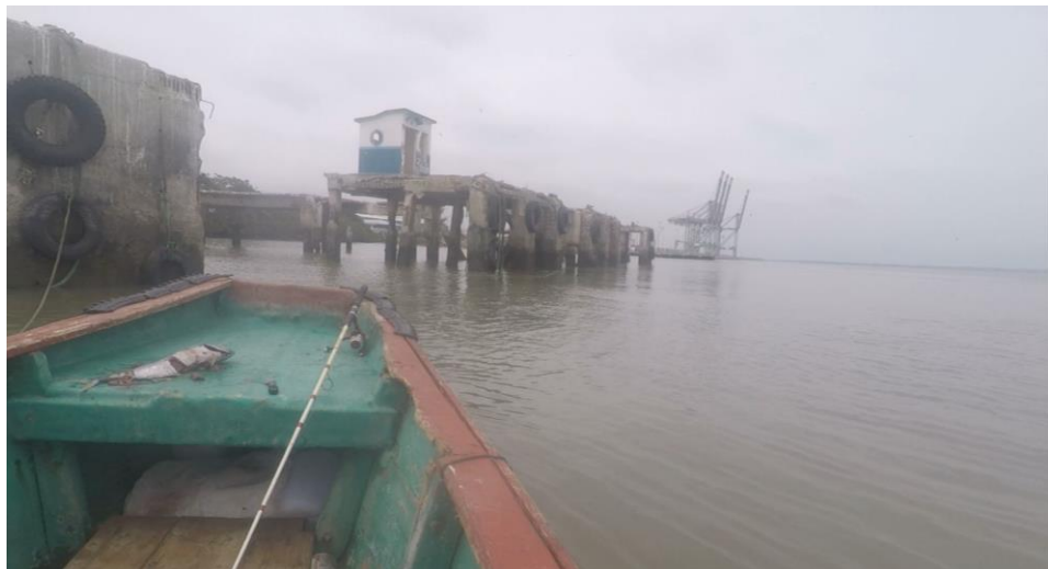
Figura 7 Muelle para amarrar la lancha
