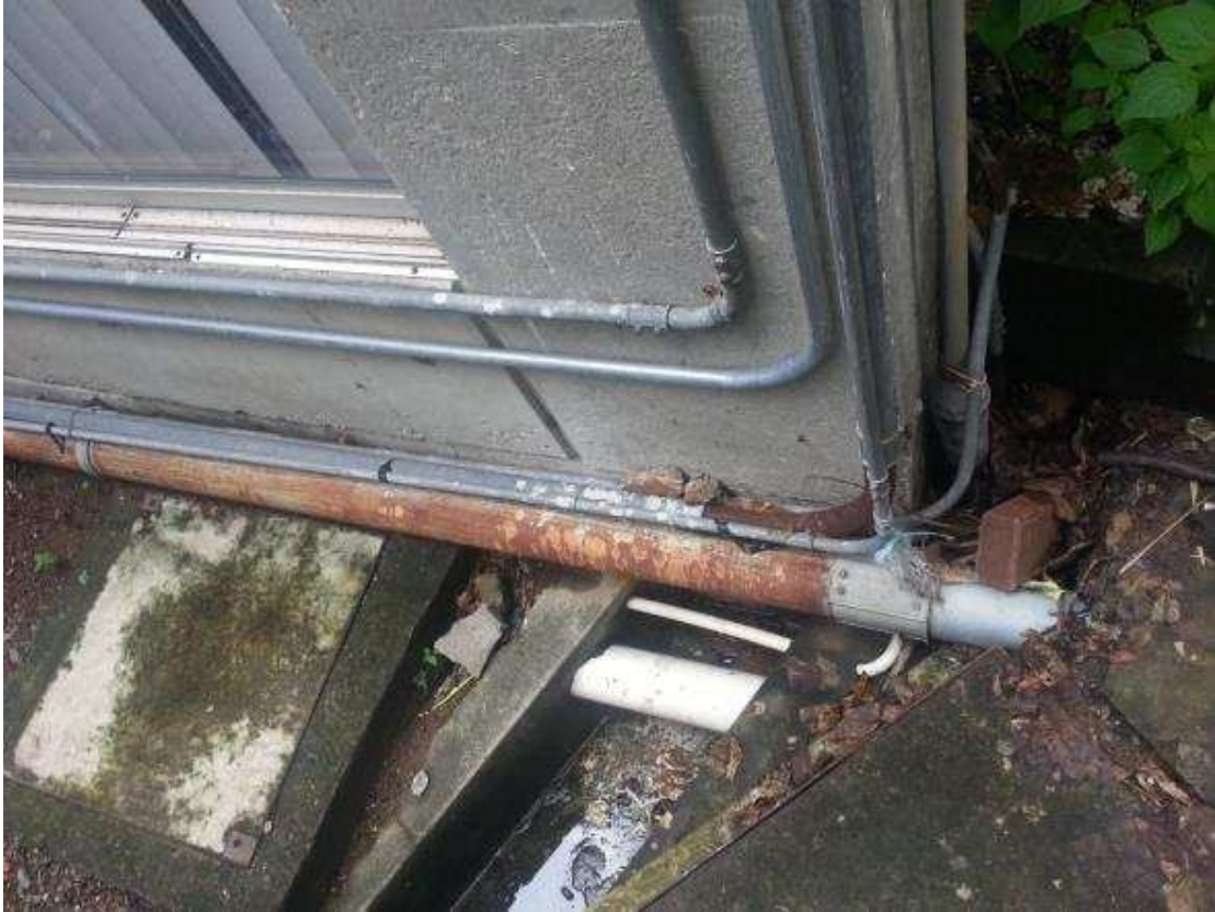
Figura 4. 3 Acometida en Media Tensión FUENTE: Autor
