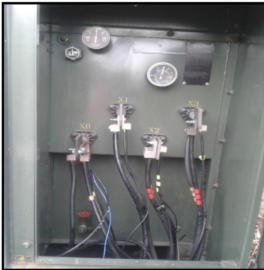
Figura 3. Transformador Pad-Mounted Ø3 ubicado por la pastoral.
