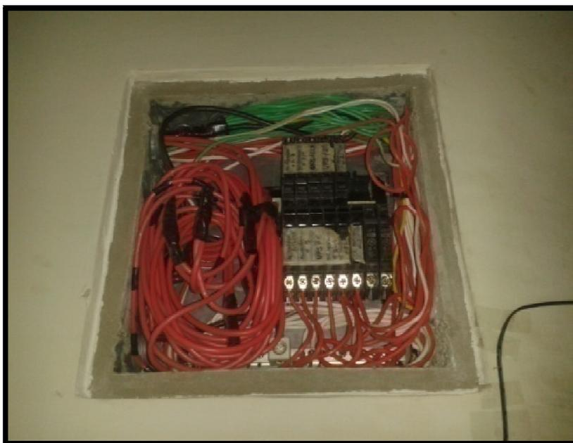
Figura 7. .Panel de distribución de seguridad "Federación"
