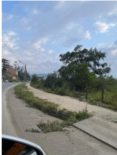
Figura 34. Vía deteriorada que llega hasta El Portete
