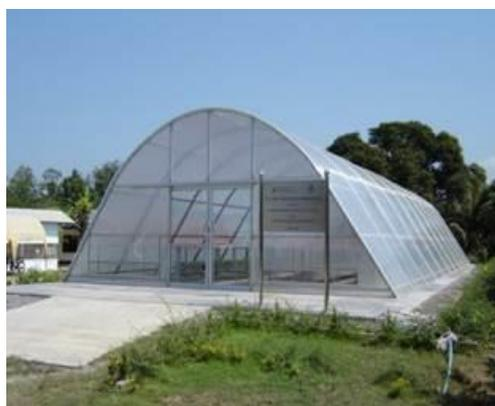
Figura 2. 8: Secador Tipo túnel de policarbonato
