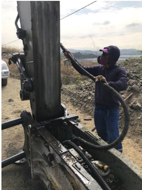
Figura 3. 15: Conexión de manguera a líneas adicionales de excavadora Fuente: El autor
