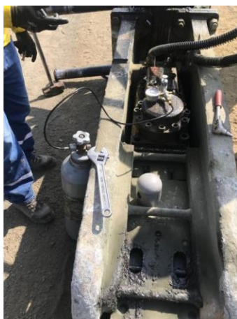
Figura 3. 6: Tanque de gas nitrógeno conectado a acumulador
