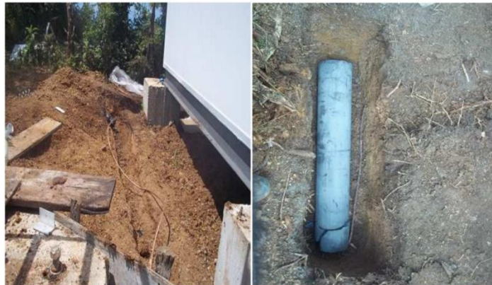
Figura 2. 24: Puesta a tierra del pozo. Fuente: (Mazur, 2014)
