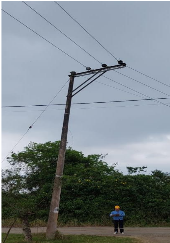
Anexo 11 Estructura 3SA trifásica para Angulo Fuente: El Autor.
