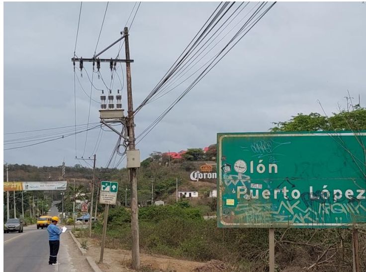
Anexo 15 Reconector de corte "Tía de montaña" NC alimentador Olón Fuente: El Autor.
