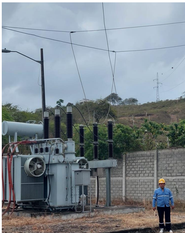
Anexo 8 Línea subtransmisión de 69 kv sistema internacional nacional Fuente: El Autor.
