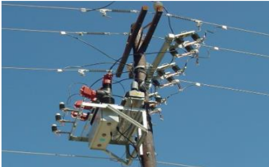
Figura 25. Manual de estructura Reconector
