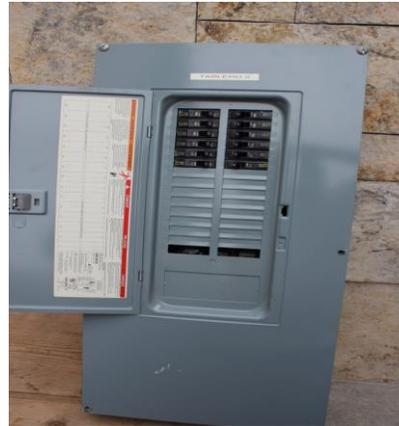
Fig. 2.11. Centro de Carga con Disyuntores.
