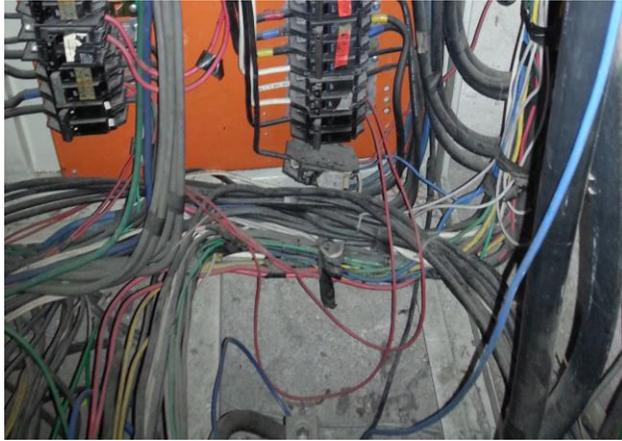
Fig. 13.15. Conductores Sueltos
