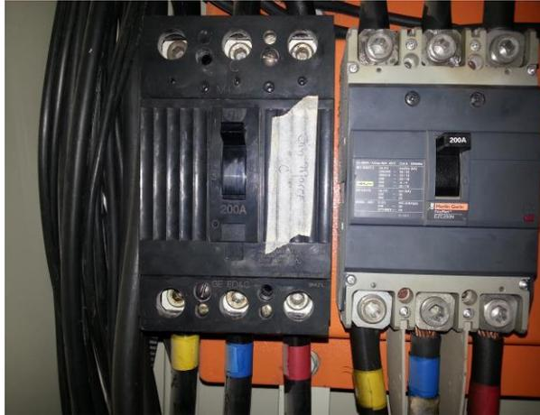
Fig. 3.17. Conductores sin Ajuste
