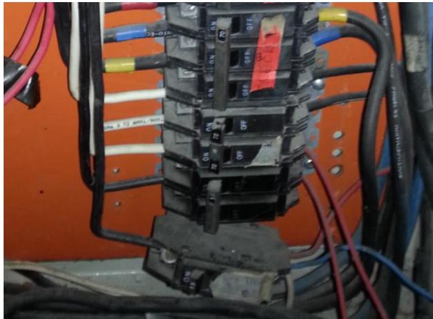
Fig. 3.16. Breaker sin Fijación
