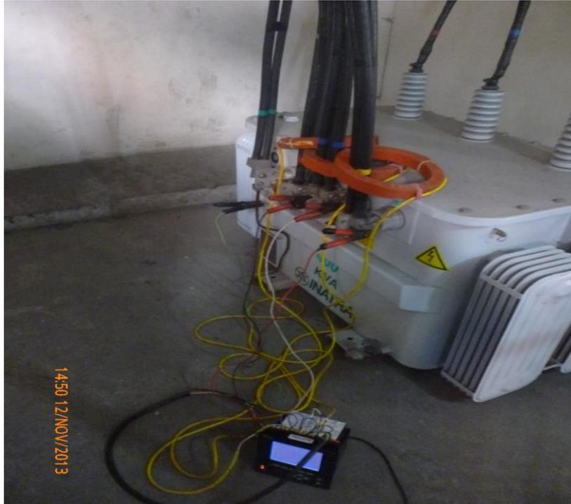
Fig.3.4. Conexiones en Baja Tensión con el Power Logic ION 7650.
