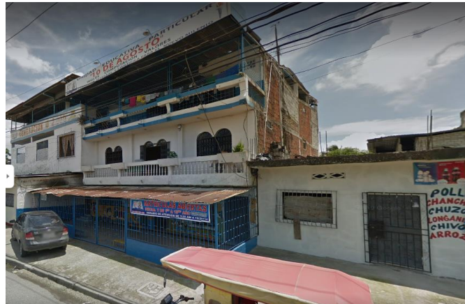
Figura 19. Fachada exterior de la Unidad Educativa Particular “10 de Agosto”
