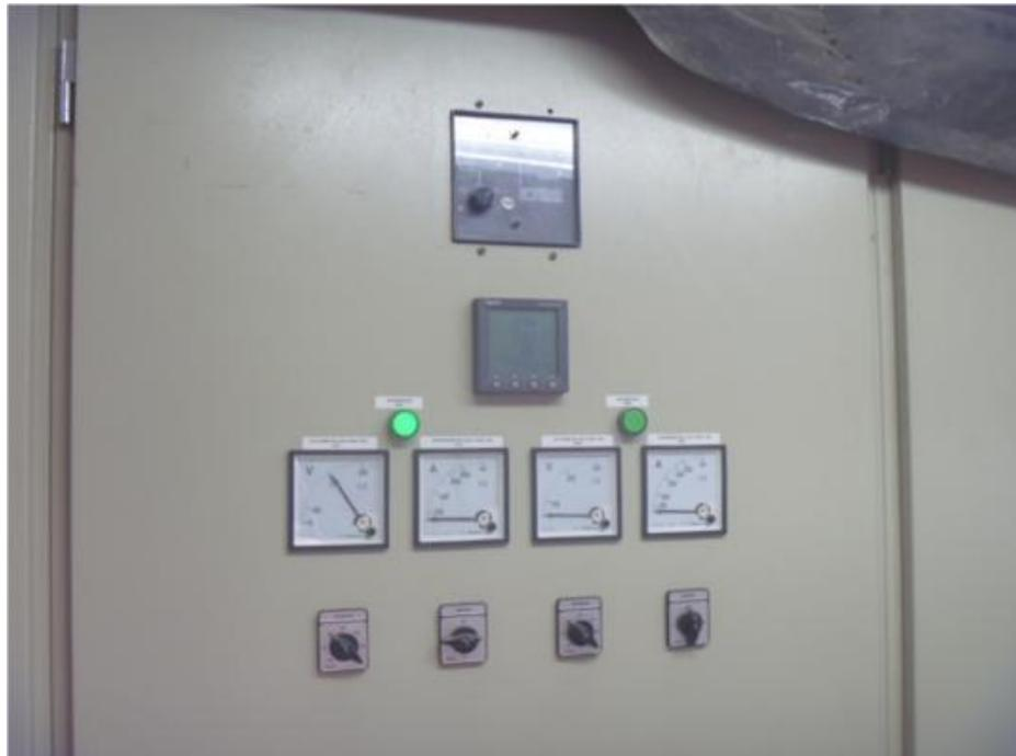
Figura 4.7 Tablero Principal con equipo de medición Powerlogic
