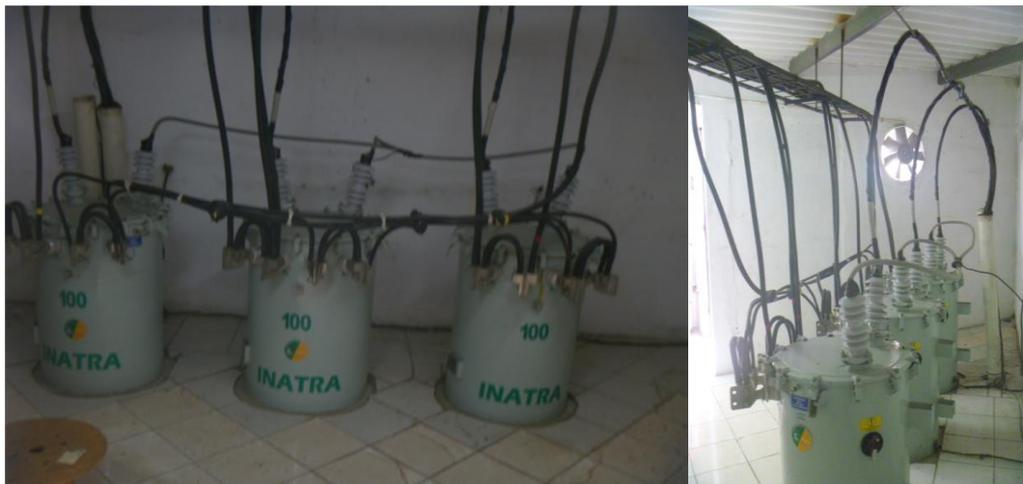
Figura 4.4 Transformadores de 100 KVA monofásicos
