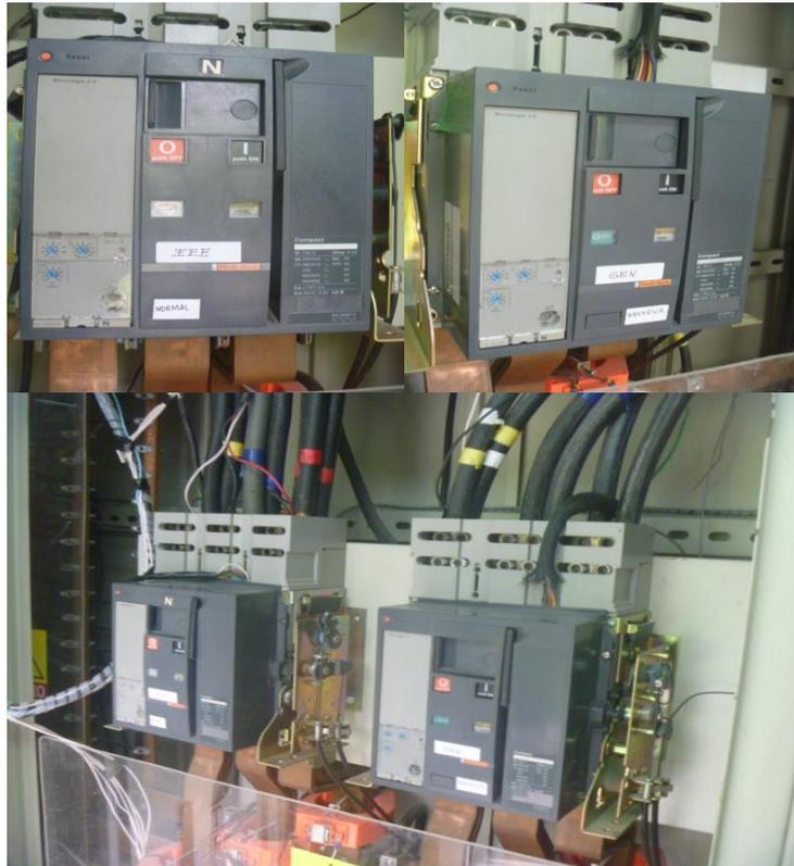
Figura 4.9 Vista de los breaker principales de transferencia
