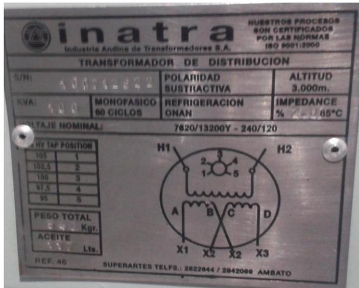
Figura 4.5 Placa de Transformador de 100 KVA monofásicos
