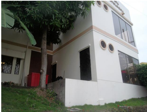
Figura 3.2. Ubicación del cuarto de transformador de Odontología
