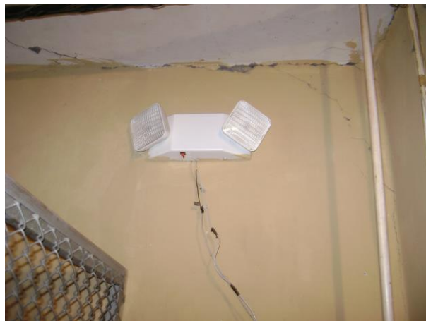
Figura 3.10. Luces de alumbrado de emergencia del banco de transformadores Y abierto aterrizado - \Delta abierto aterrizado
