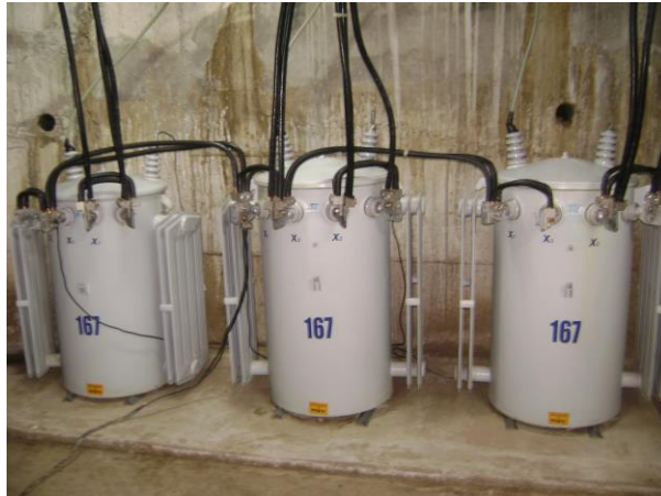
Figura 4.7. Colocación de bases para banco de transformadores trifásico
