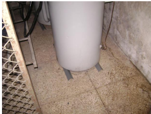
Figura 4.5. Colocación de bases para banco de transformadores Y abierto aterrizado - \Delta abierto aterrizado
