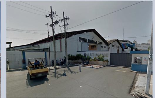
ASTINAVE (Guayaquil, Ecuador) 1972, se creó Astilleros Navales Ecuatorianos como empresa industrial naviera; con galpones con estructura metálica y bloque para sus paredes, puertas industriales metálicas.
