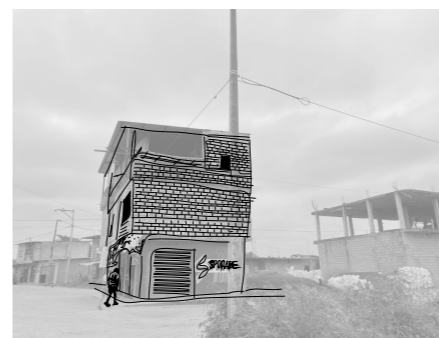
Fuente: El autor, 2021 Vivienda de tres pisos diagonal al terreno del proyecto
