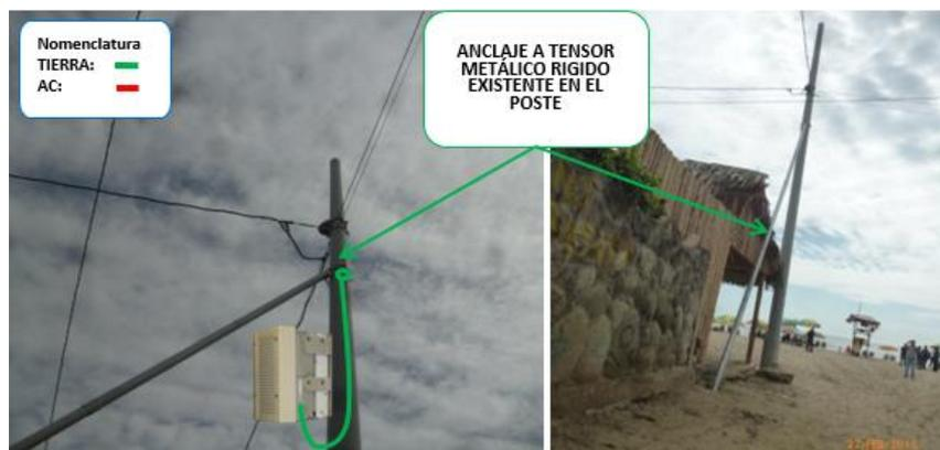
Fig. 3.7 Montaje de la Metrocell Outdoor
