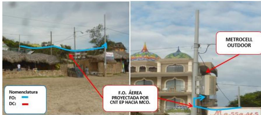
Fig. 3.8 Cableado de Transmisión de Fibra Óptica
