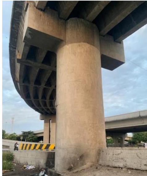
Ilustración 11. Pila #16 del paso elevado con columna circular. Fuente: Elaboración propia de autor.
