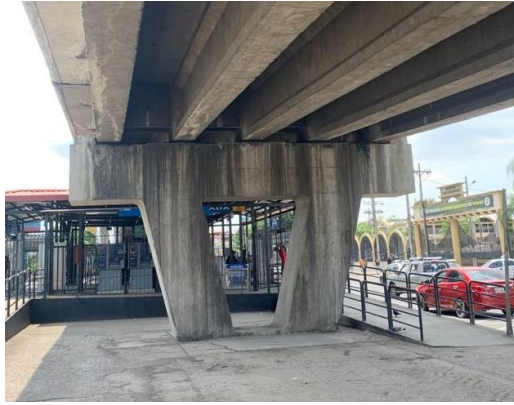
Ilustración 9. Pila #3 del paso elevado con columnas rectangulares inclinadas. Fuente: Elaboración propia de autor.
