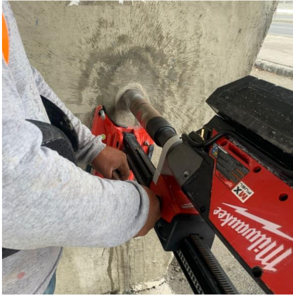
Ilustración 37. Perforación con broca especial. Fuente: Elaboración propia de autor.
