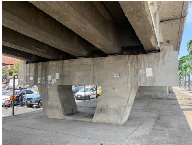
Ilustración 34. Pila #2 seleccionada para extracción de núcleo. Fuente: Elaboración propia de autor.
