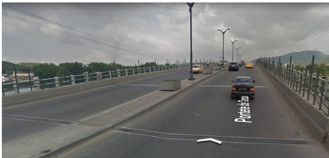
Ilustración 55. Puente de la Calle Portete. Extraída de Google Earth.
