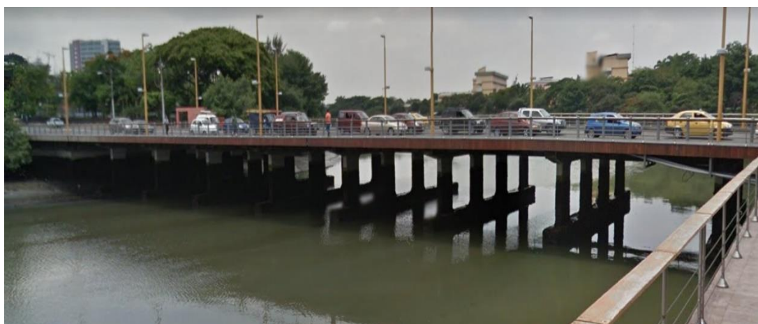
Ilustración 17. Puente 5 de Junio. Extraído de Google Earth.
