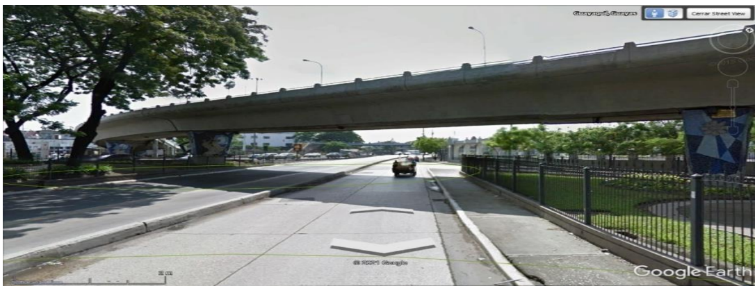
Ilustración 24. Paso a desnivel de la Av. Julián Coronel y las Av. Machala. Extraído de Google Earth.
