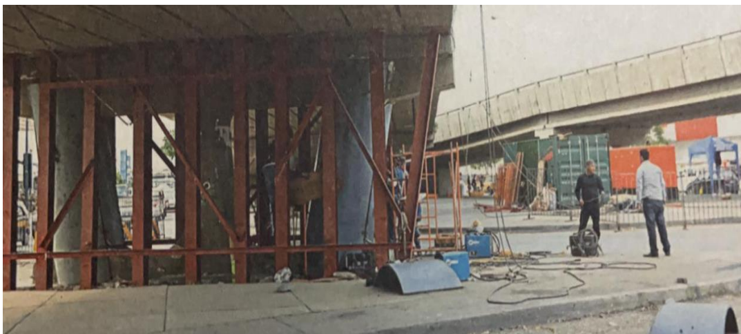
Ilustración 47. Encamisado de las pilas del a desnivel en la intersección de la Av. De las Américas con la Av. Kennedy. Extraído del diario Expreso.
