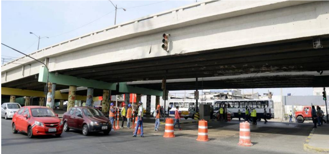
Ilustración 20. Puente veinticinco de Julio, trabajos ejecutados. Extraído del diario El Universo,2016.
