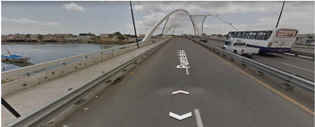
Ilustración 61. Puente de la calle A (Pío López Lara). Extraído de Google Earth.
