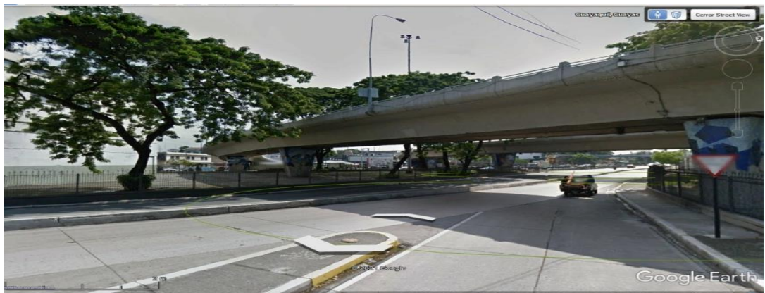
Ilustración 23. Paso a desnivel de la Av. Julián Coronel y las Av. Quito. Extraído de Google Earth.
