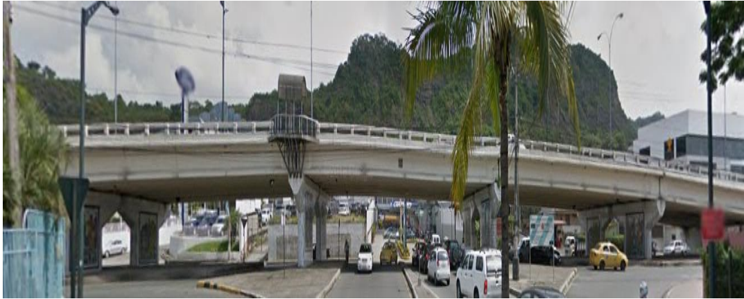
Ilustración 56. Paso a desnivel de la Av. Carlos Julio Arosemena con la Av. Las Monjas, frente a diario Expreso. Extraído de Google Earth.
