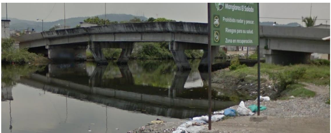
Ilustración 36. Puente de la G. Extraído de Google Earth.
