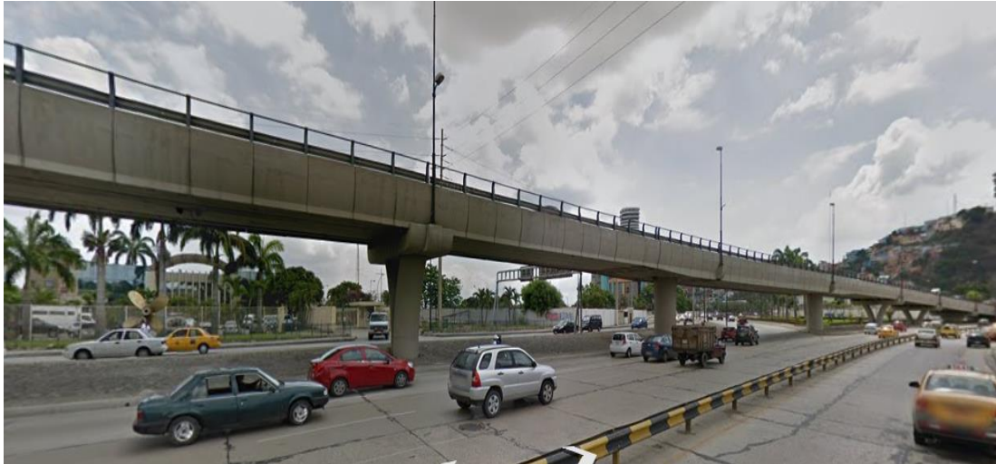
Ilustración 62. Paso a desnivel en la Av. Pedro Menéndez Gilbert a la altura del Hospital Solca. Extraído de Google Earth.
