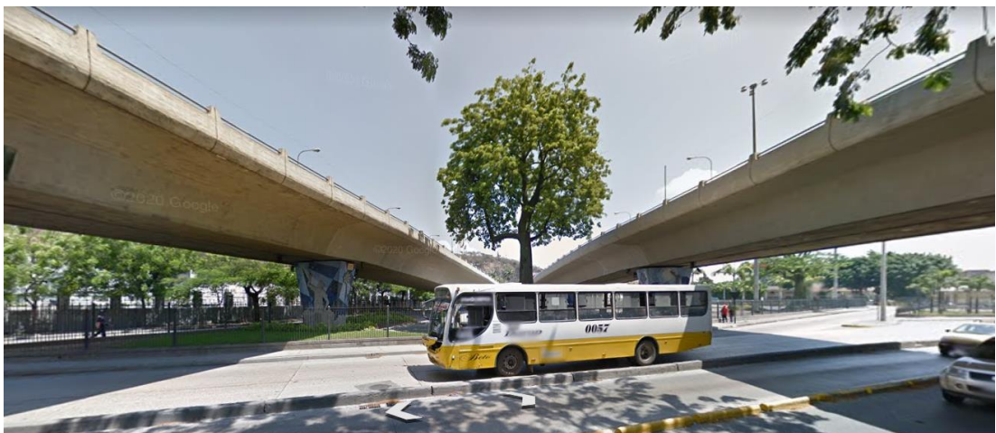
Ilustración 50. Paso a desnivel de la Av. Julián Coronel y las Avenidas Quito y Machala. Extraído de Google Earth
