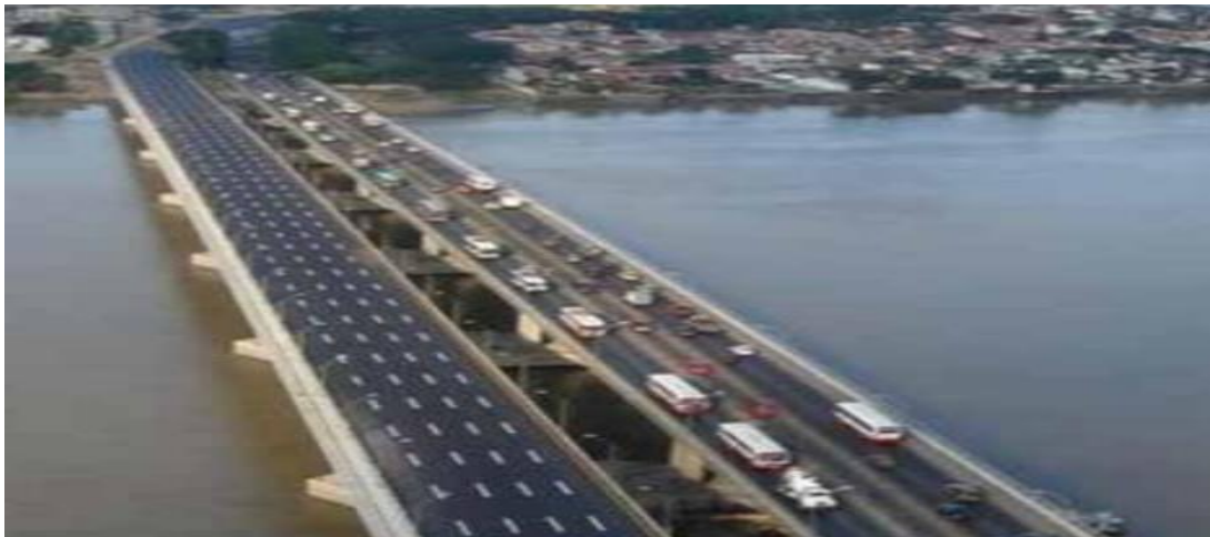
Ilustración 6. Puente Rafael Mendoza Avilés. Extraído del sitio web Obras Públicas.gob.ec, 2011.
