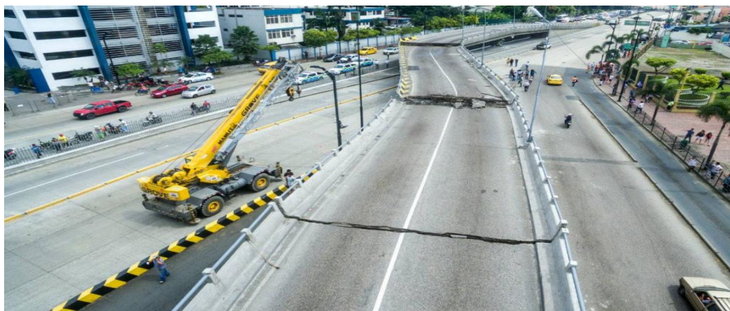
Ilustración 46. Paso a desnivel en la Av. De las Américas, frente a la Policía y Universidad Laica, consecuencias del terremoto del 16 abril del 2016. Extraído del diario El Universo.
