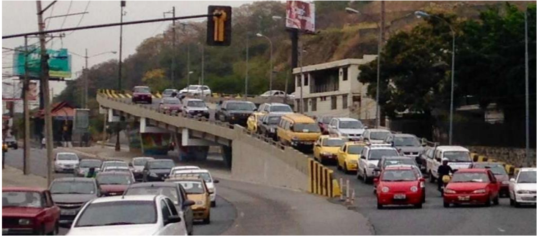
Ilustración 27. Paso a desnivel que conecta la Ciudadela Bellavista con la Av. Carlos Julio Arosemena. Extraído del diario El Telégrafo.
