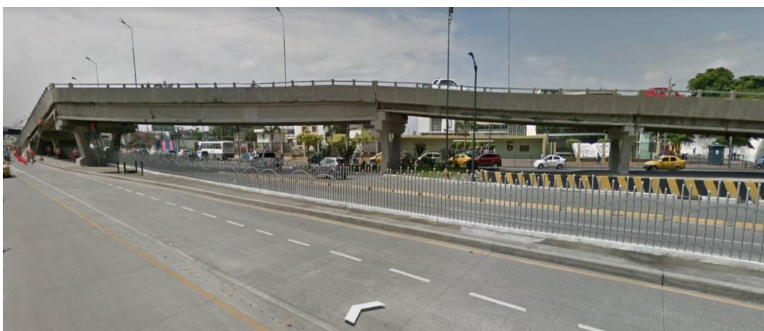
Ilustración 34. Paso a desnivel de la av. de las Américas, frente a la Policía y Universidad Laica. Extraído de Google Earth.
