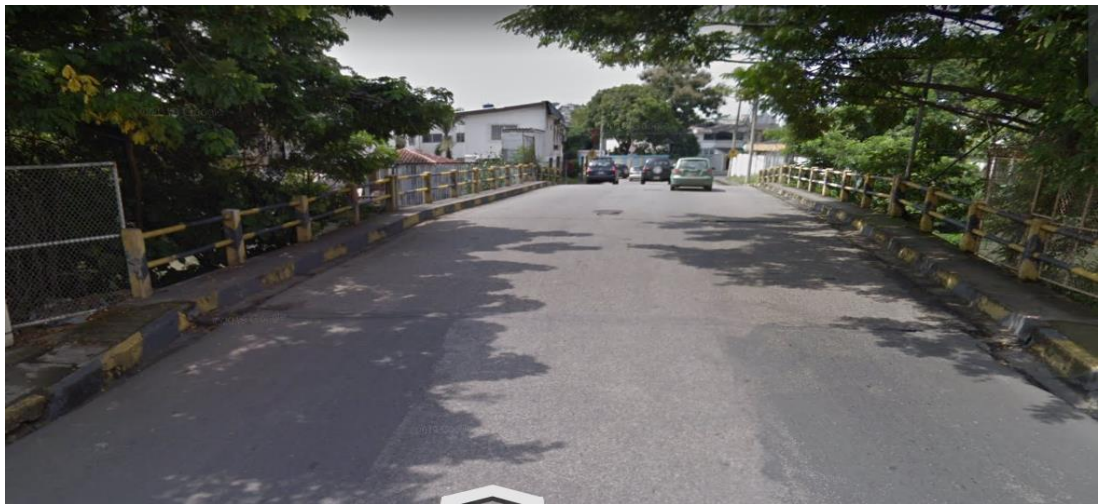
Ilustración 18. Paso a desnivel que conecta la Av. Ignacio Cuesta (Av. Central) con la Jorge Pérez Concha, sobre el estero salado. Extraído de Google Earth.
