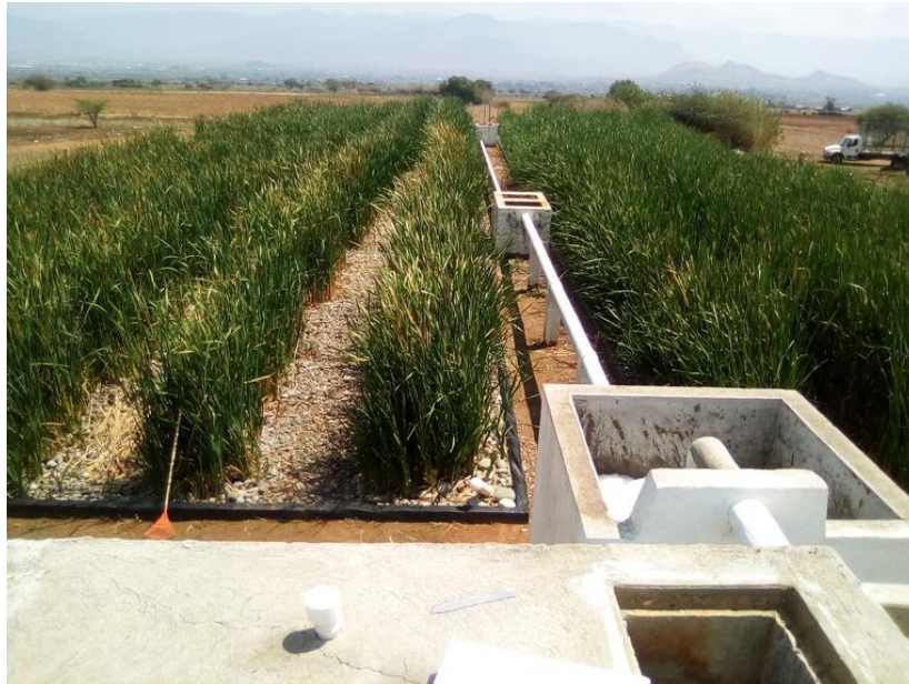
Ilustración 3.- Vista típica de un humedal artificial.
