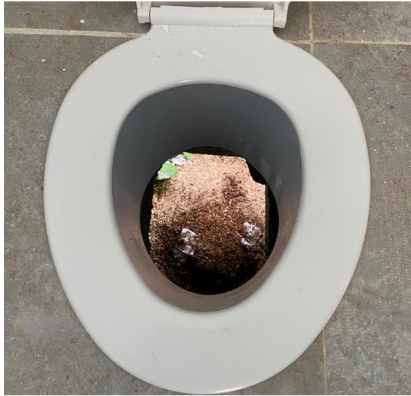
Figura 12. Pozo Séptico o baño seco, foto tomada en visita técnica el día 04 de junio de 2021.
