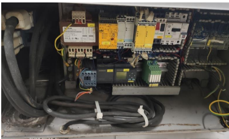
Figura 43 Sistema de Control en Emulsificador
