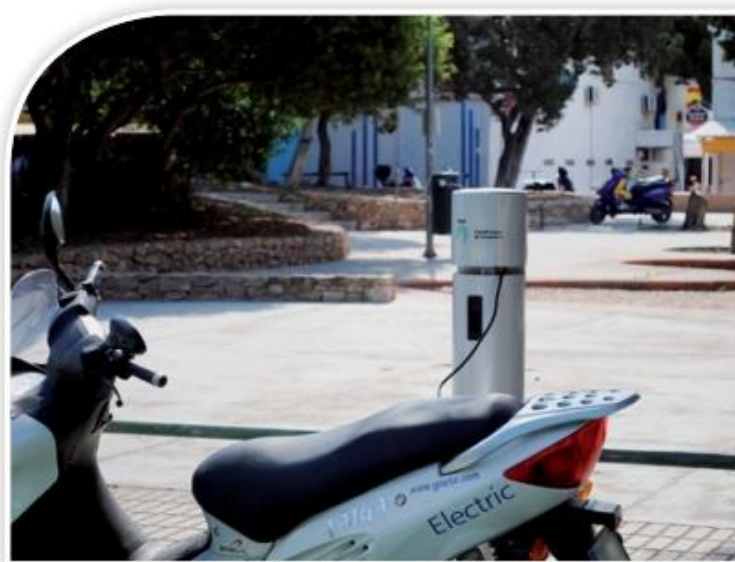
Figura 4. 3: Recarga de vehículos eléctricos en Islas Baleares.
