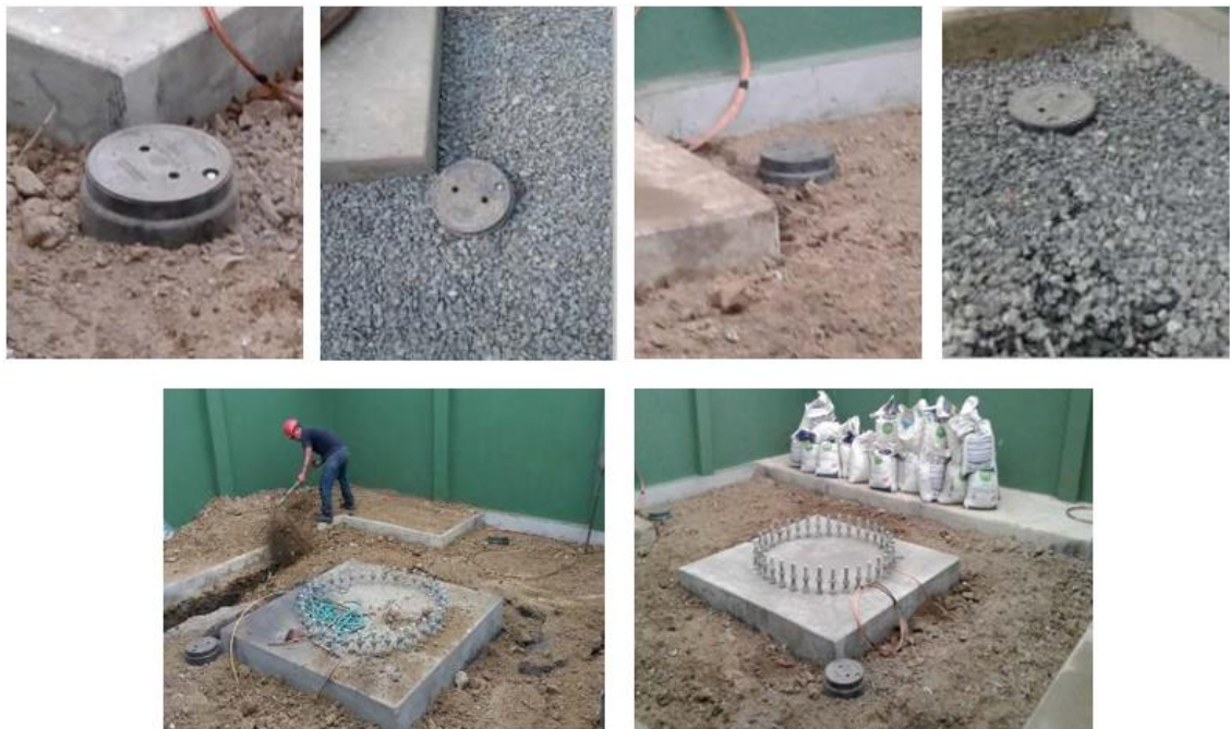
Figura 4. 4 Aplicación de acoplador de tierra Thor Gel y compactación y relleno de zanjas.
