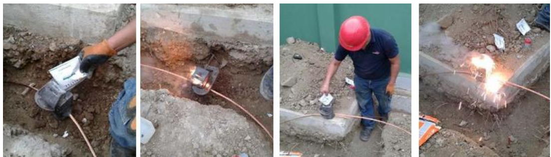
Figura 4. 2 Proceso de soldado de exotérmico
