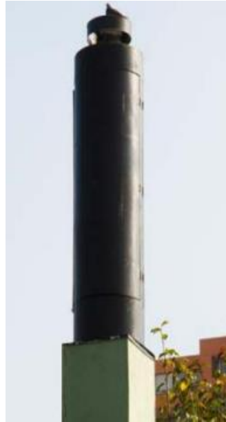
Figura 3. 5 . Mimetización tipo chimenea
