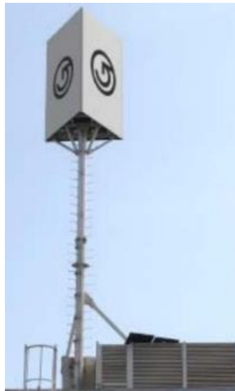
Figura 3. 9 Mimetización de mástil autoportado con vallas publicitarias
