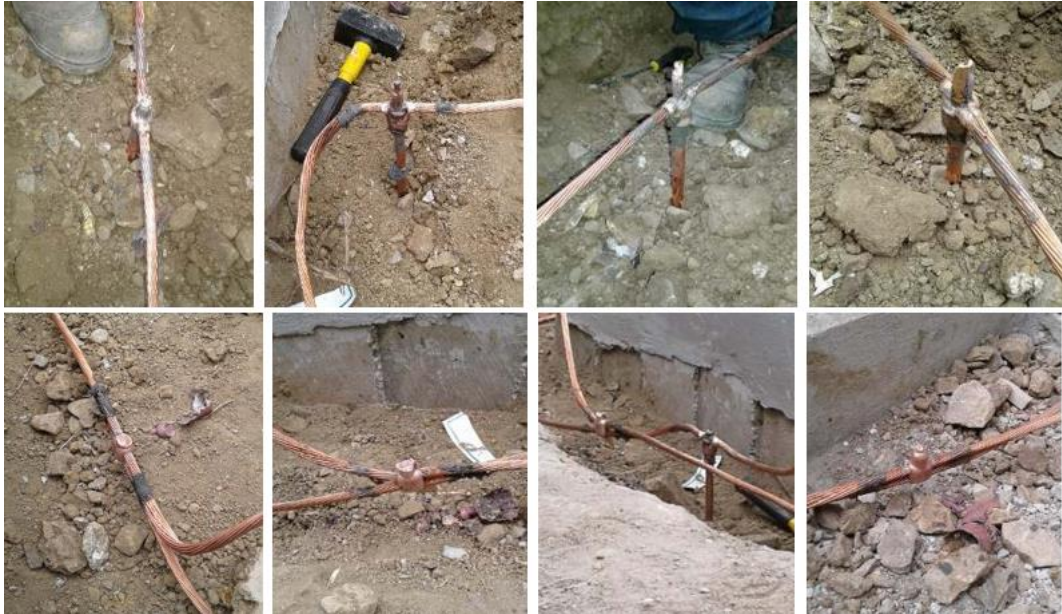
Figura 4. 3 Soldadura exotérmica de varillas de cable.
