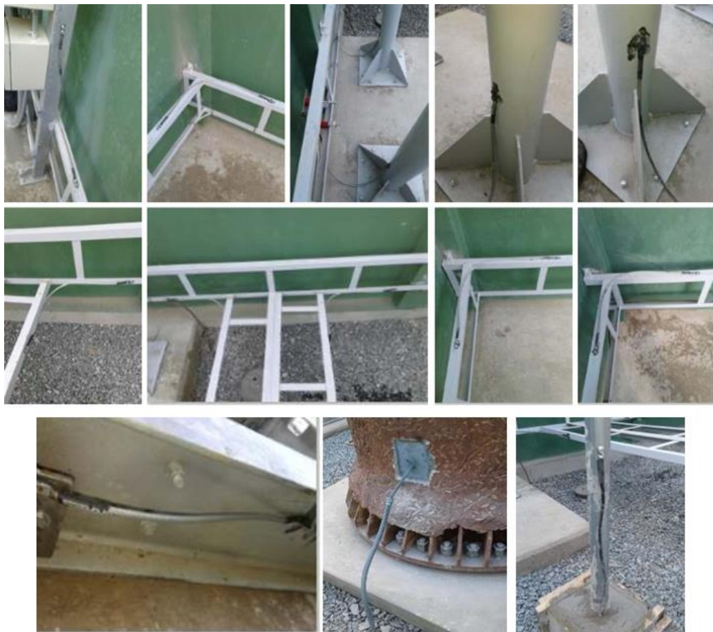
Figura 4. 6 Trabajos realizados con el aterrizamiento de todas las estructuras metálicas.
