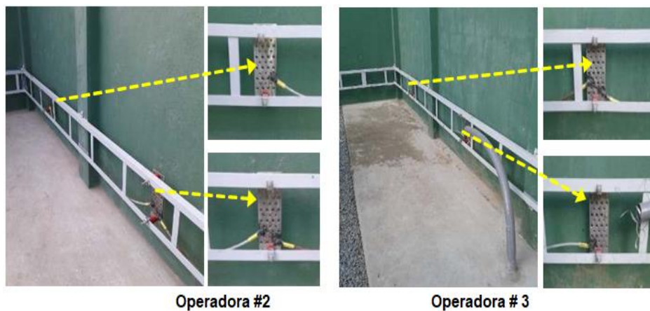
Figura 4. 8 Sistema de barras de otros radiobases
