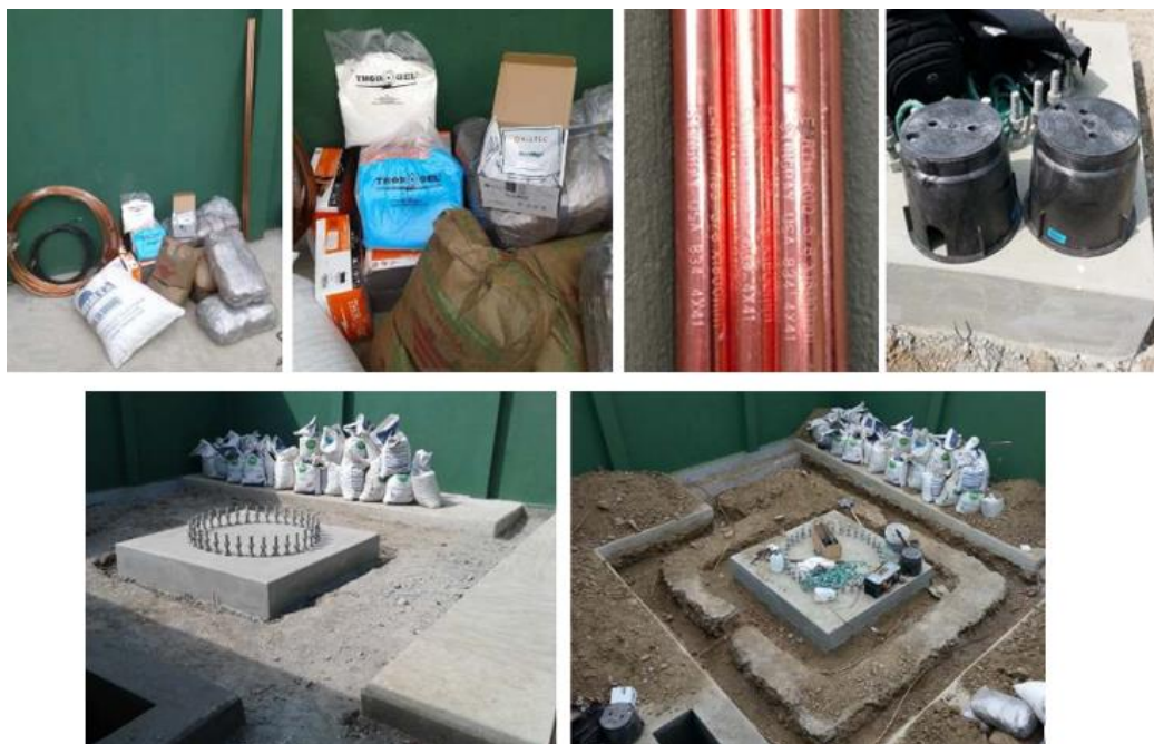
Figura 4. 1 Materiales para realizar los trabajos con SPAT
