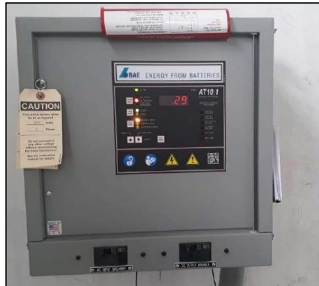
Figura 2. 14. Cargador de Baterías Fuente: (Medina, 2018).
