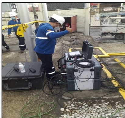
Figura 3. 18. Prueba de factor de potencia Fuente: El autor, (2021)
