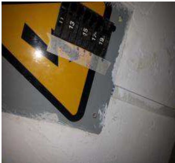
Figura 4.22. PB - Lab.Tel. Ubicado en el Lab. de Telecomunicaciones de la Facultad.
