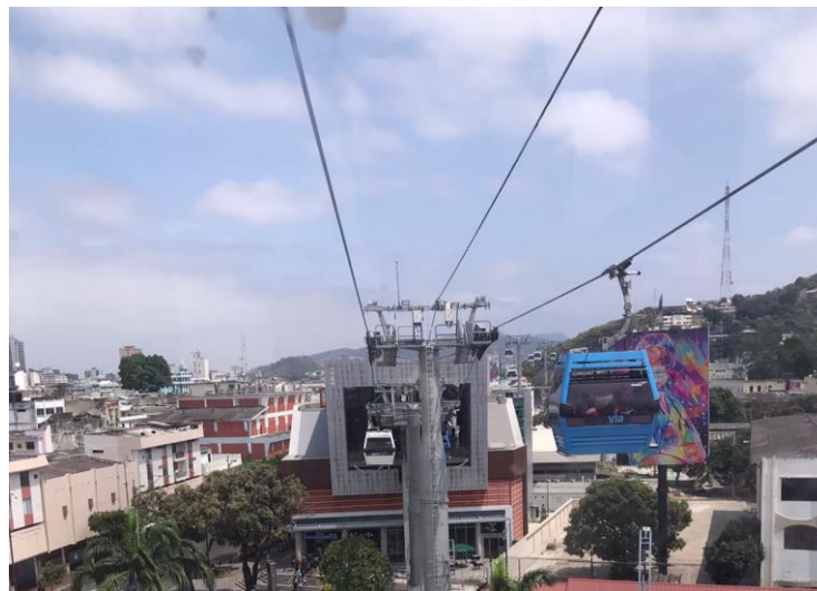
Figura 2. 20 Suspensión aérea de las cabinas (Fuente: Autor)
