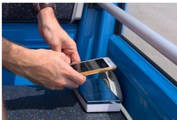
Figura 3. 6 Instalación de un Enerwi en la aerovía (Fuente: El Autor)
