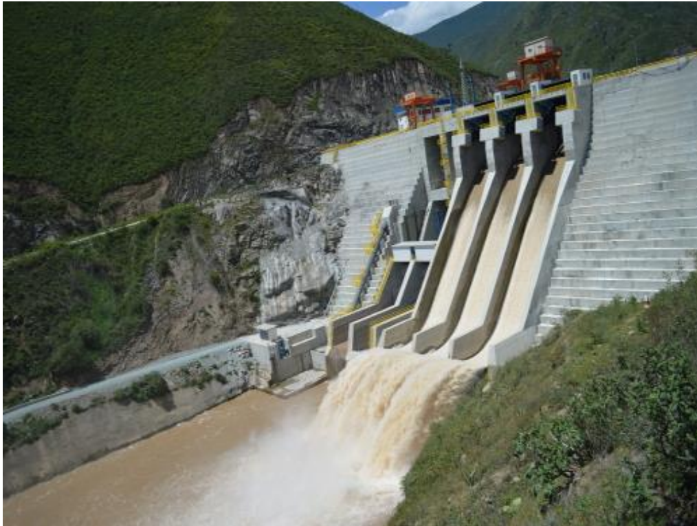
Figura 18 Laúd de hidroeléctrica Minas San Francisco
