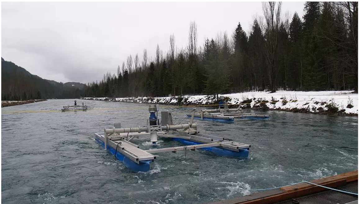
Prueba de turbinas In-stream en Duncan Dam
