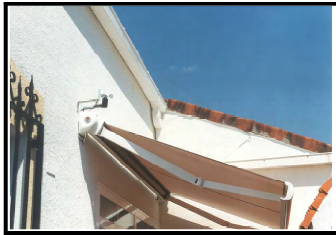
Fig. 2.41 Motorización de toldo, con recogida y extensión automática en función de sol y viento.
