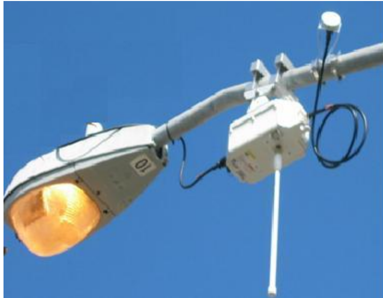
Figura 6. Instalación de la Serie Mesh AP 1500 (CISCO SYSTEM , 2005)
