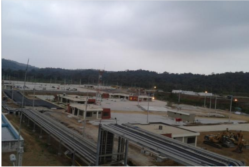
Figura 2.9 Vista del área administrativa de la terminal “El Chorrillo”
