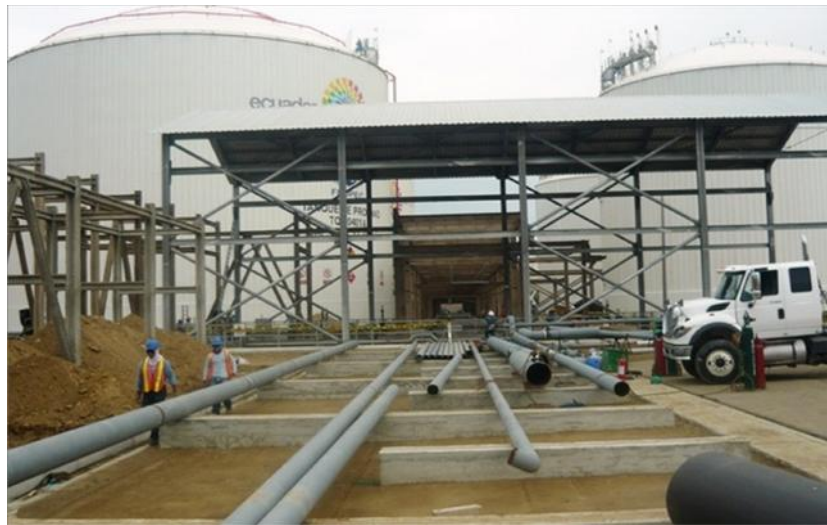
Figura 2.8 Instalación de tuberías en tanques de almacenamiento de GLP Fuente: Terminal el Chorrillo (2013)
