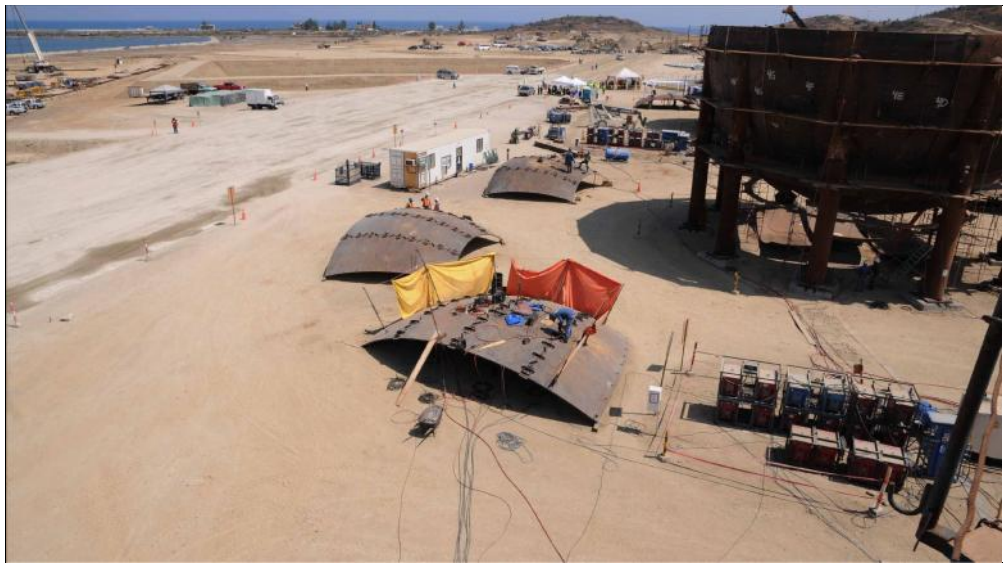
TRABAJOS EN TERMINAL GLP- EL CHORRILLO
