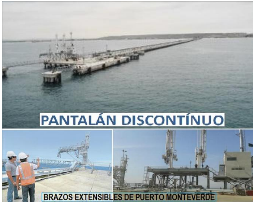
Figura 2.3 Pantalán discontinuo y brazos extensibles del puerto Monteverde Fuente: Conferencia Planta GLP, zona Sur-Ecuador, Bucaramanga, 12 de noviembre de 2013. Edición fotográfica por Carlos Medina.
