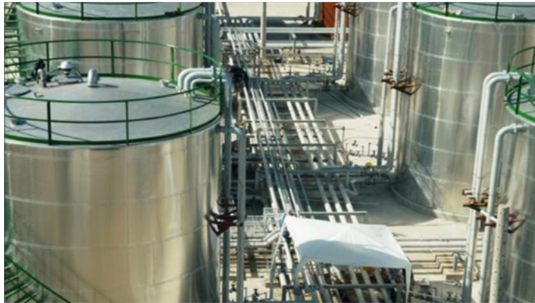
Figura 2.7 Instalación de tuberías en plantas de GLP
