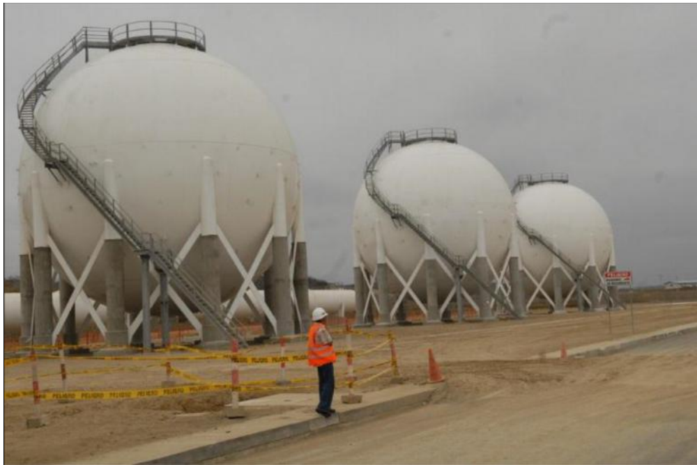
CONSTRUCCIÓN DE ESFERAS PARA ALMACENAR GLP SOBRE TIERRA
