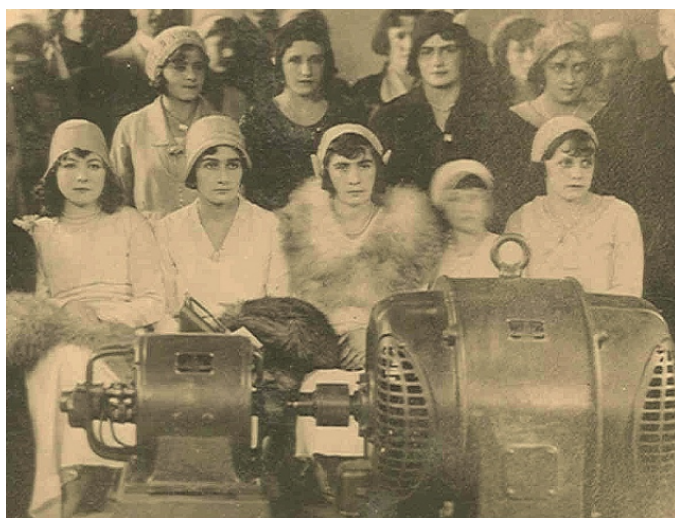
Figura 2.2 Inauguración de la Empresa Eléctrica Municipal Fuente: ( http://www.eerssa.com/nuestra-empresa/historia.html?showall=1 , 2011)
