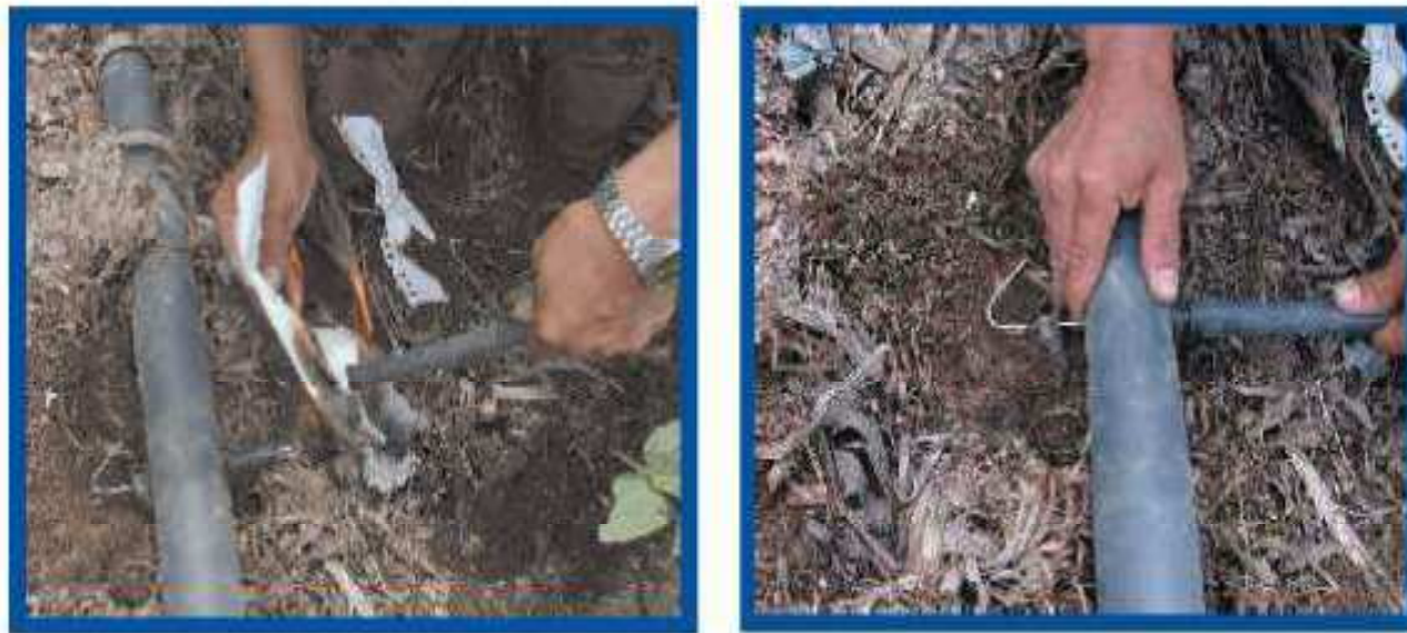
Figura 6.13e Demostración de cómo asegurar debidamente la tubería
