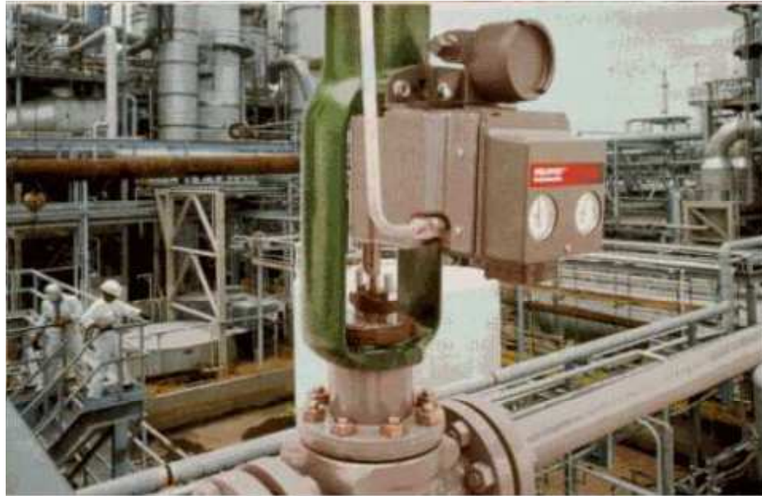
Figura 5.6.3.2 Válvula con Posicionador Electro neumático HART
