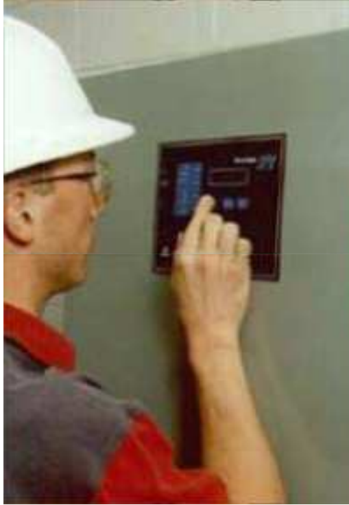
Figura 1.6.3 Ejemplo de una RTU stand-alone simple
