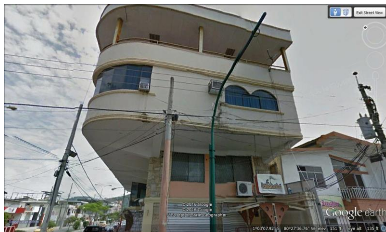
Figura 19: Edificio del Sr. Pedro Ramírez antes del sismo del 16 de abril
