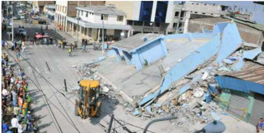
Figura 14: Edificio en Ayacucho y García Moreno después del Sismo 2016
