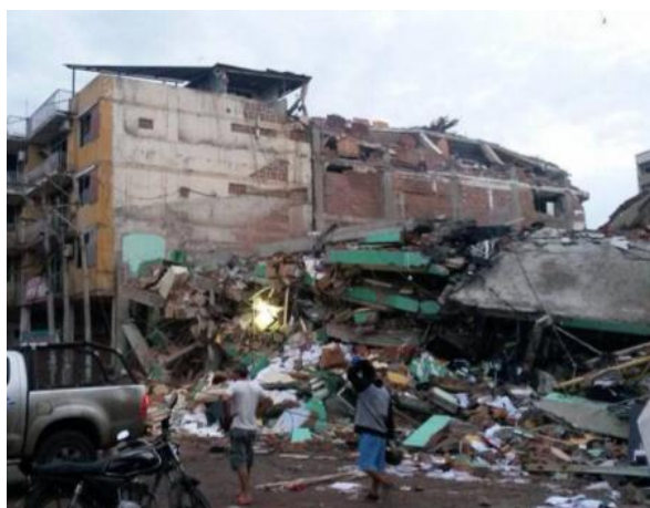
Figura 18: Edificio del IESS después del sismo del 16 de abril
