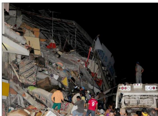
Figura 32: Centro comercial derrumbado en Manta
