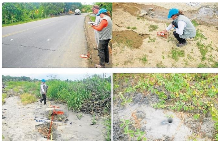
Figura 31: Volcanes y grietas de arena en la zona afectada por el sismo
