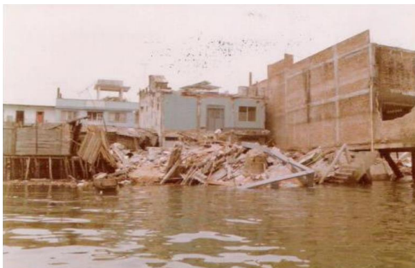
Figura 1: Daños ocasionados por el Tsunami en Tumaco
