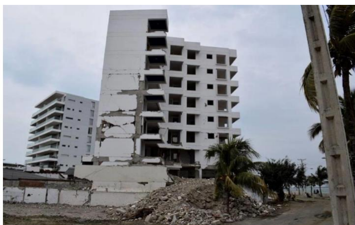
Figura 29: Edificio El Almirante después del sismo - parte lateral del inmueble
