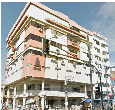
Figura 17: Edificio del IESS antes del sismo del 16 de abril
