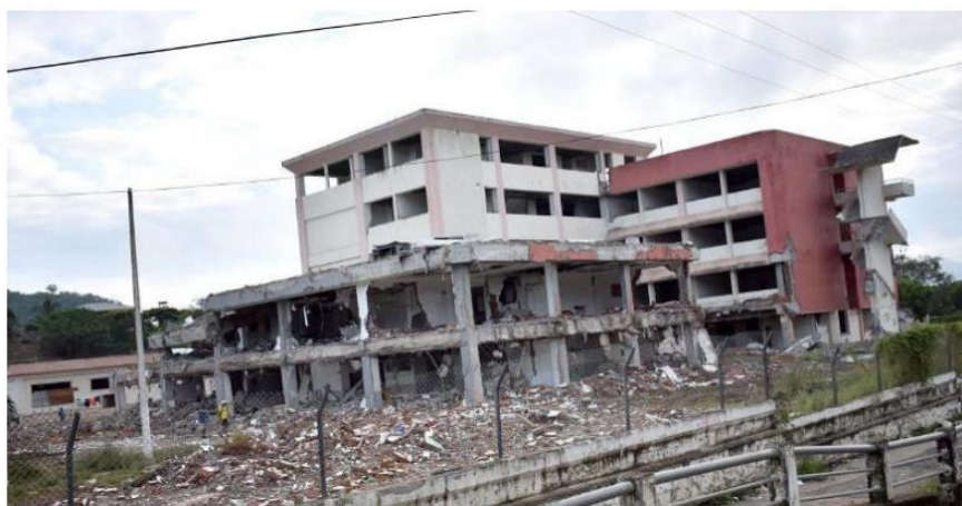
Figura 28: Hospital Miguel H. Alcívar durante su demolición
