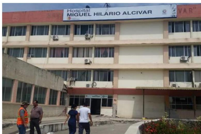
Figura 27: Fachada del Hospital Miguel H. Alcívar en Bahía de Caráquez después del sismo
