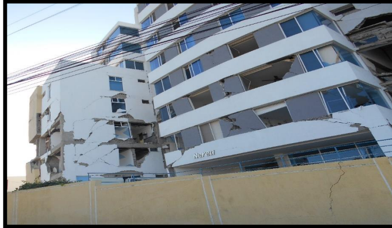
Figura 24: Edificio Nerea, ubicado en Manta después del sismo
