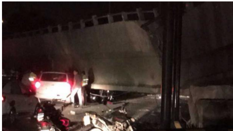
Figura 10: Intercambiador de Tráfico en Av. de las Américas
