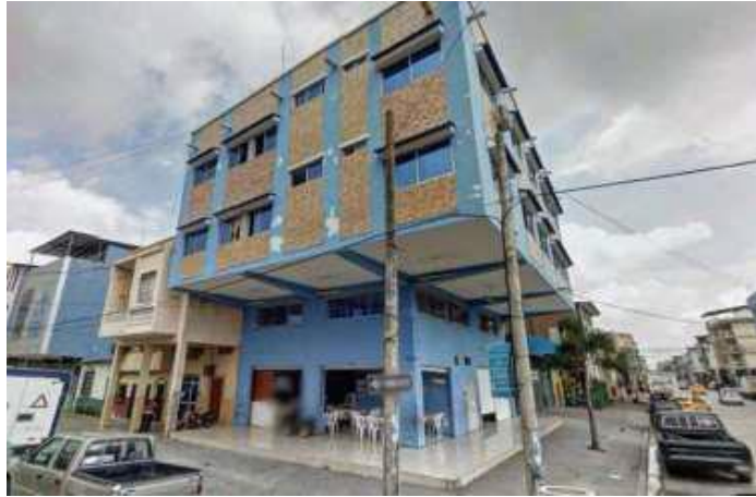
Figura 13: Edificio en Ayacucho y García Moreno antes del Sismo 2016
