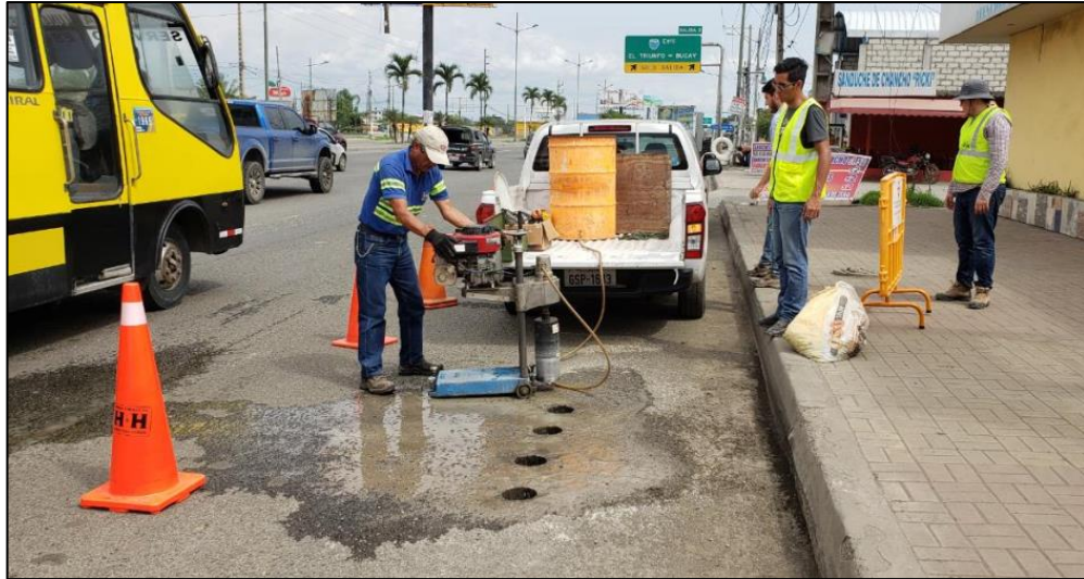
Figura 13. Extracción de núcleos de la avenida Lapentti con 15 años de colocación
