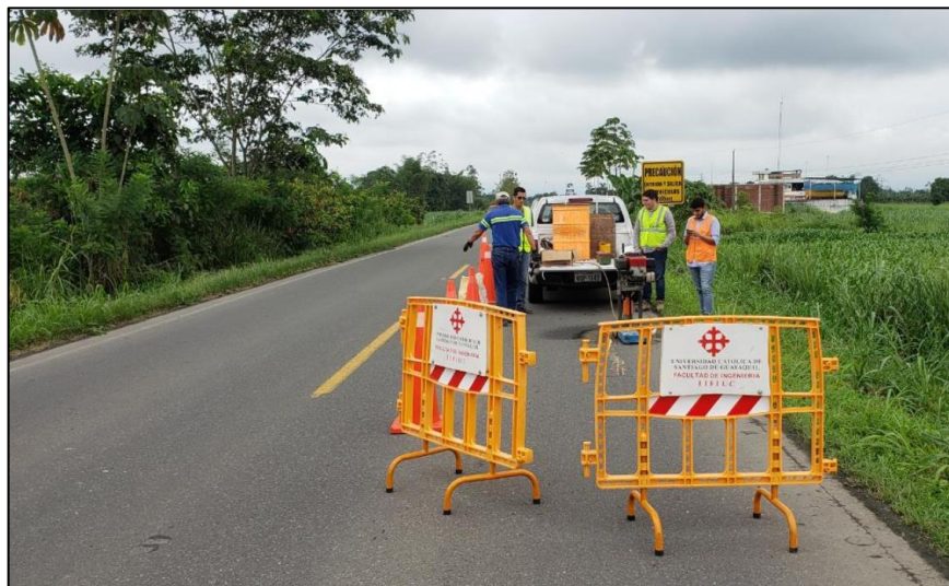
Figura 12. Extracción de núcleos de la vía Milagro- Naranjito- Bucay con 8 años de colocación
