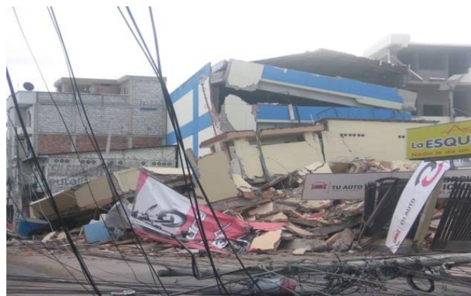
Ilustración 35 Escombros del Edificio Palau
