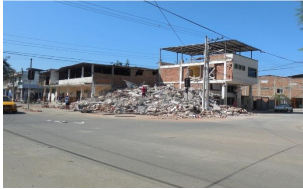
Ilustración 39 Escombros de la Clínica Yanqui
