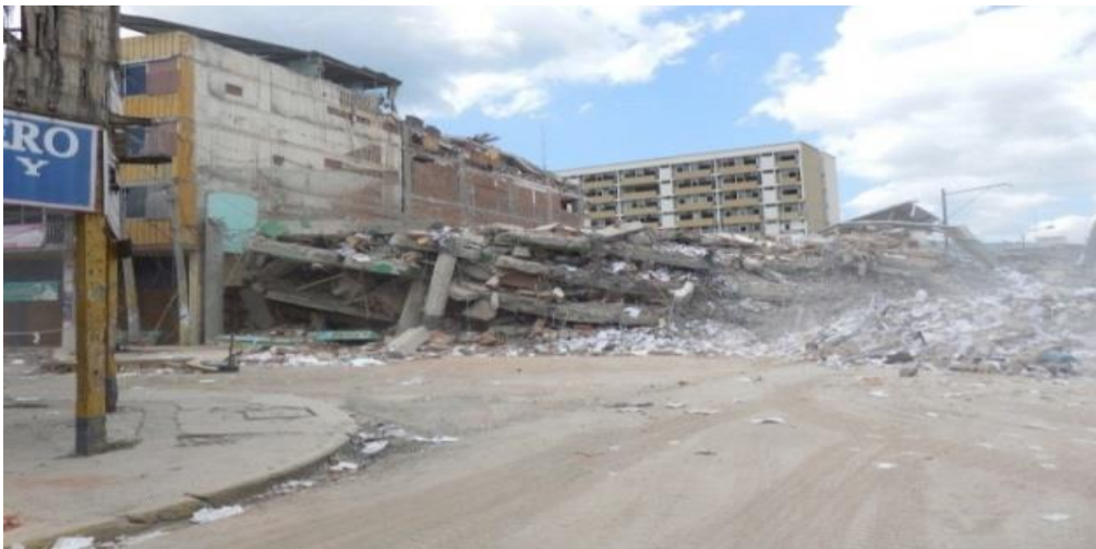
Ilustración 33 Colapso del Edificio IESS después del sismo de 2016
