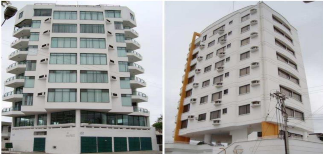
Ilustración 15 Evidencia de pisos blandos en las construcciones. Izquierda Edificio Nautilus. Derecha, Edificio Salango. Fuente: ESPOL
