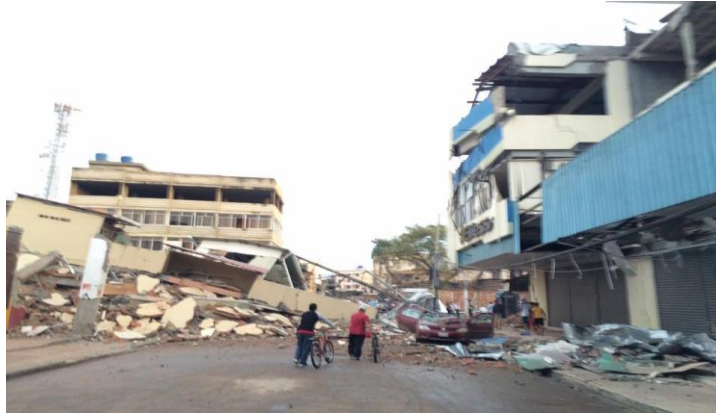
Ilustración 36 Escombros del Edificio Palau
