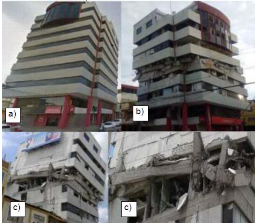
Ilustración 18 a) Edificio sin colapsas; b) edificio colapsado; d) columna débil; viga fuerte.
