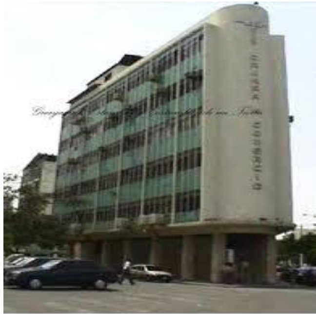
Ilustración 16 Edificio Cámara de Comercio de Guayaquil (1998)
