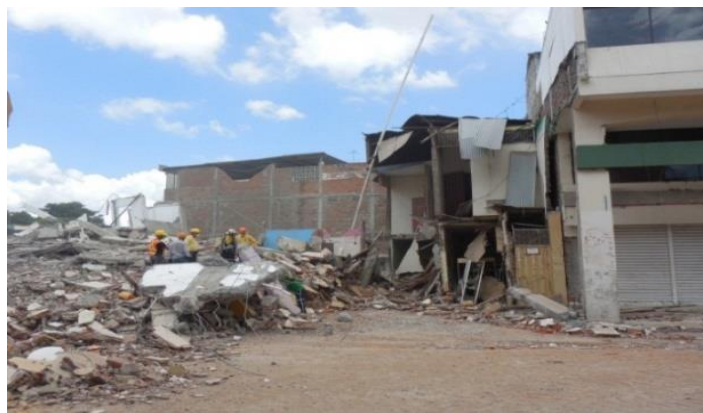
Ilustración 30 Escombros del Hotel Cabrera después del sismo del 16 de abril del 2016
