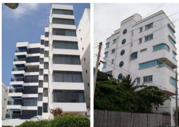
Ilustración 24 Irregularidades arquitectónicas. Izquierda: Edificio El Almirante (irregularidad en planta). Derecha: Edificio S/N (irregularidad en elevación).
